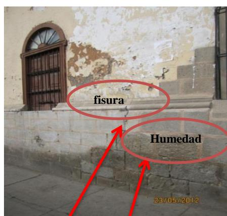
**Fig. N° 1.07.** Superficies externas con humedad contenida y fisuras presentes.
