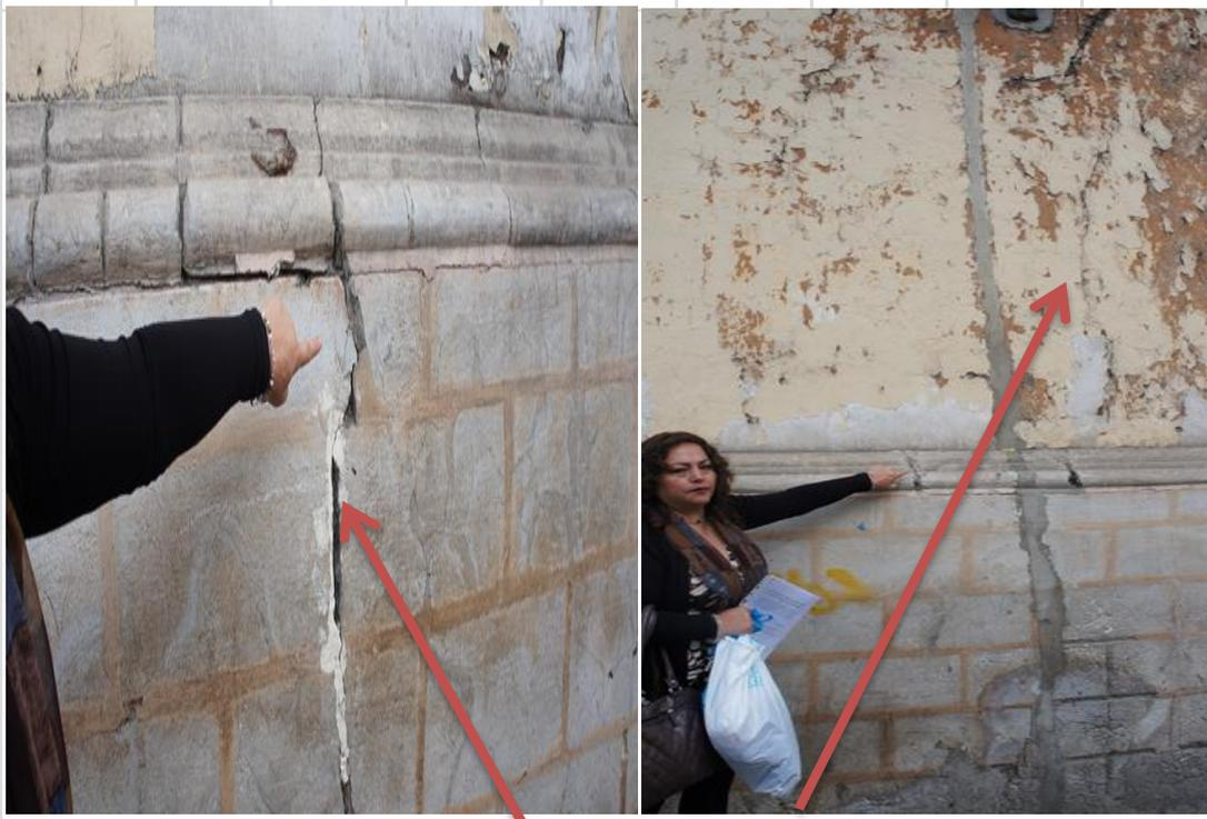
**Fotografía 4: Fachada Jr. Junin, Grieta en el zócalo de piedra y muro de adobe**
