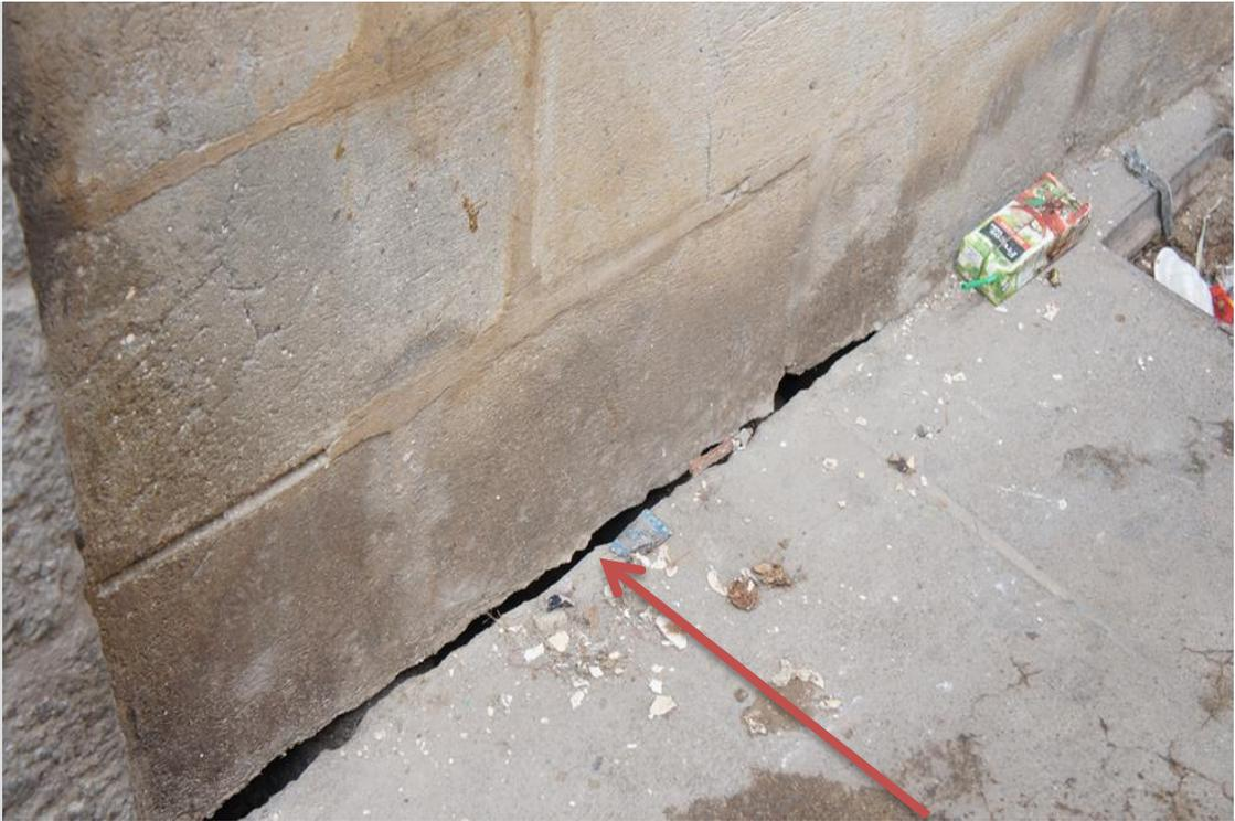
**Fotografía 5: Fachada Psje atahualpa grieta entre muro y vereda**
