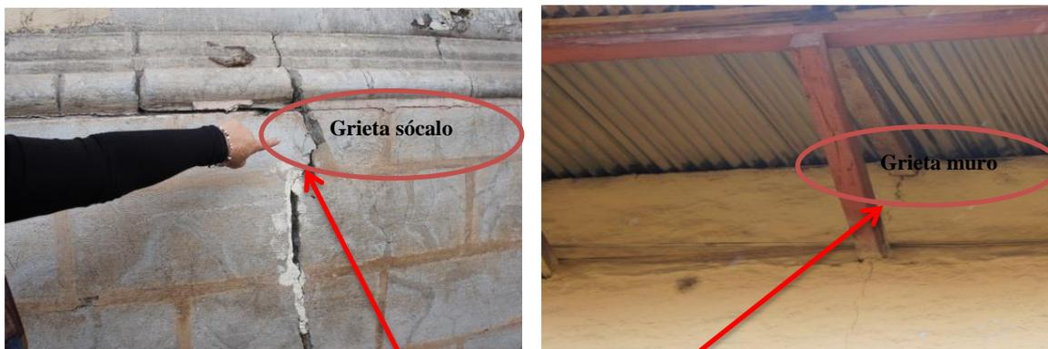
**Fig. N° 1.9.** Grieta en zócalo de piedra y muros de adobe
