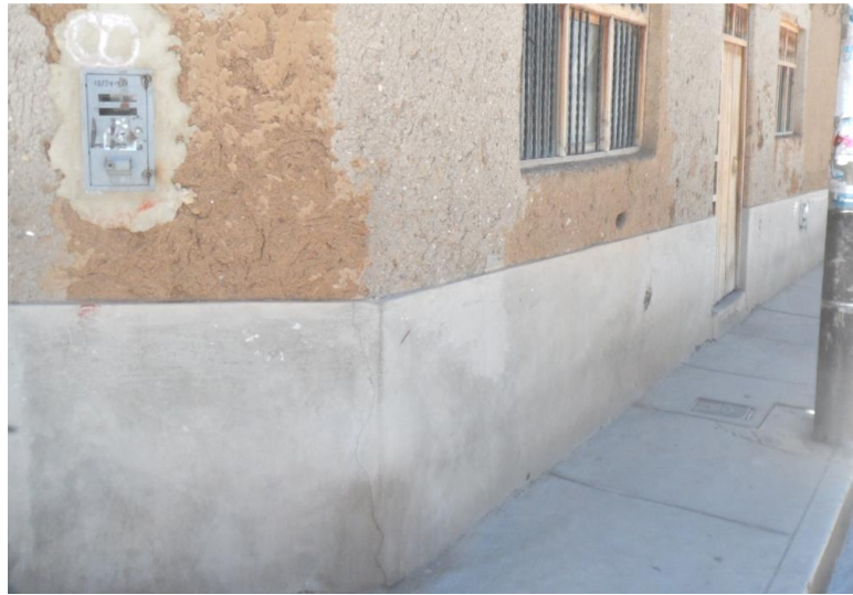
Figura 7: Zócalo de protección, de un muro de adobe, construido de mortero cemento / arena.
