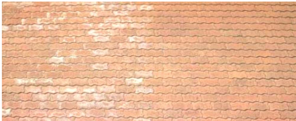
Figura 10: Disminución de eflorescencias en bloques de concreto coloreado, a la izquierda sin hidrofugar, a la derecha incorporando un aditivo hidrófugo de Sika
