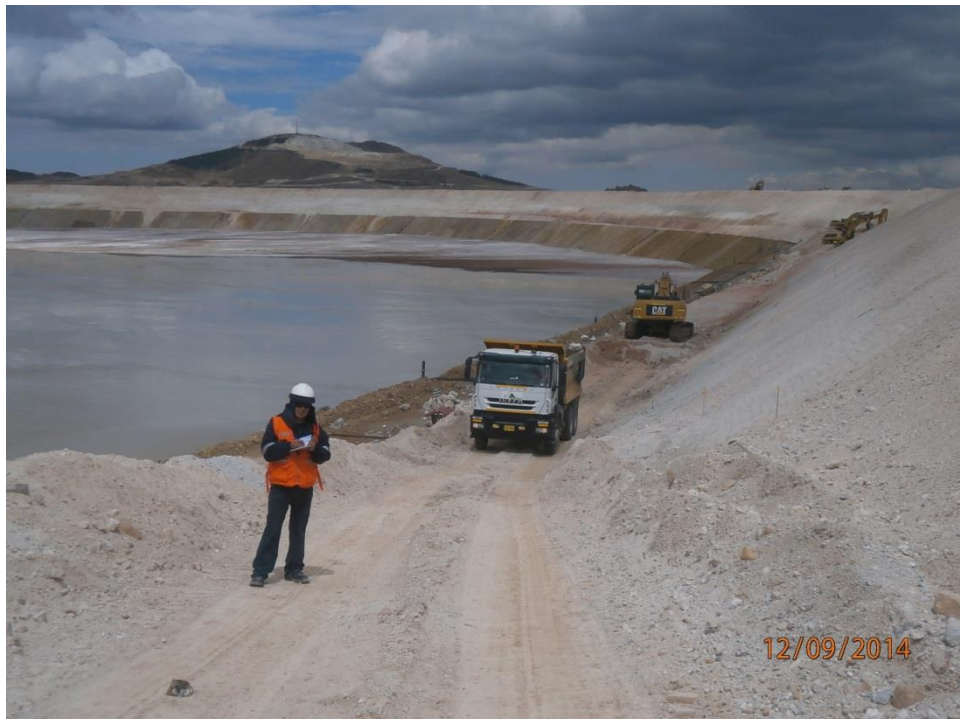
FOTO N°10: Verificación de trabajos de carguío de material (relleno común)
