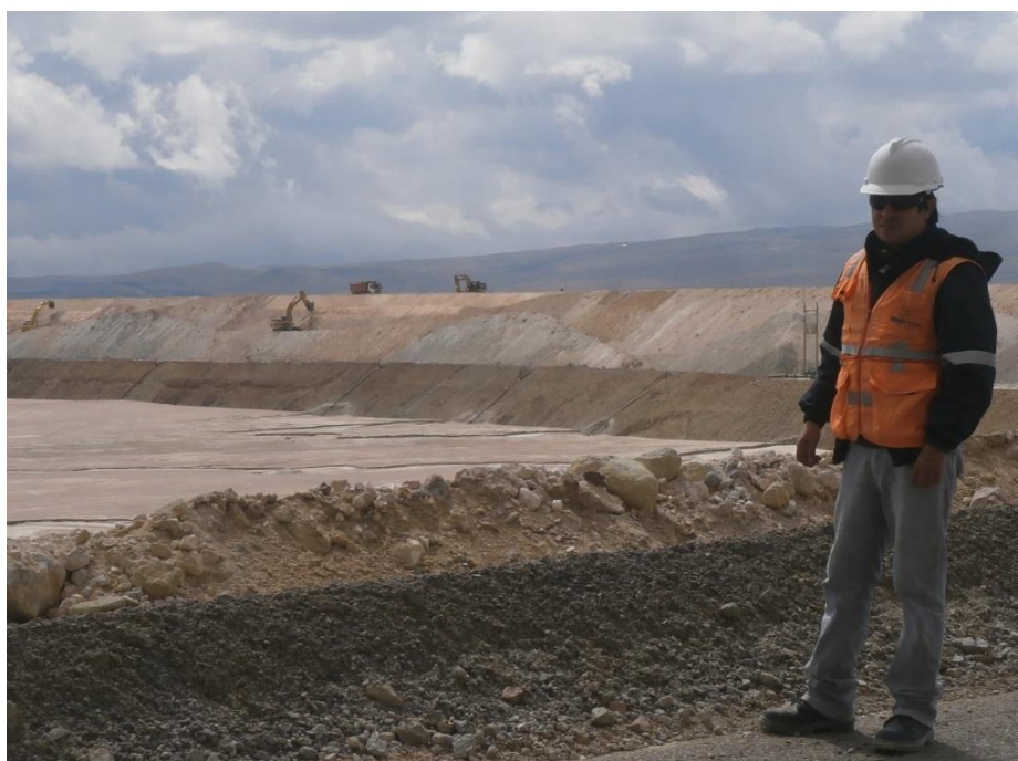
FOTO N°2: Depósito de Arenas de Molienda - La Quinua Fase IV.
