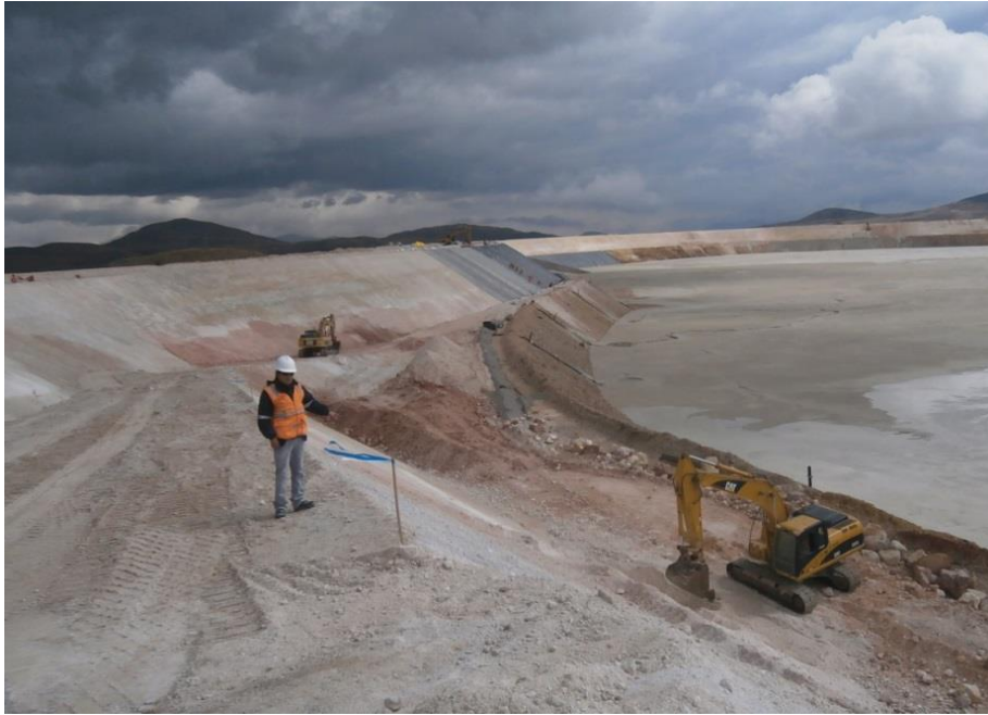
FOTO N°3 Inspeccionando trabajos de relleno común en talud.
