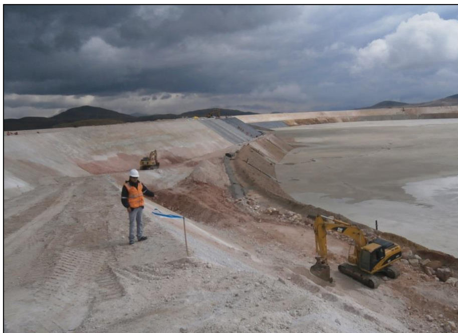
Figura 4.2: Construcción del Depósito de Arenas de Molienda- La Quinoa Fase IV
