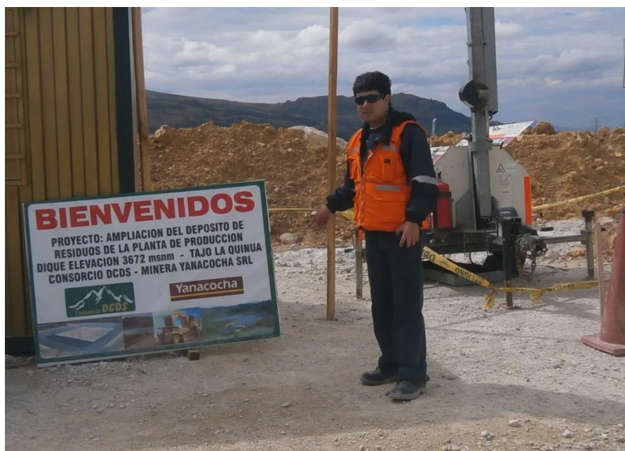
FOTO N°1 : Cartel de Obra.
