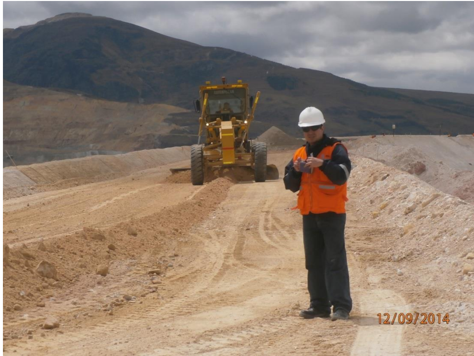
FOTO N°9: Verificación de trabajos de conformación de material (relleno común)
