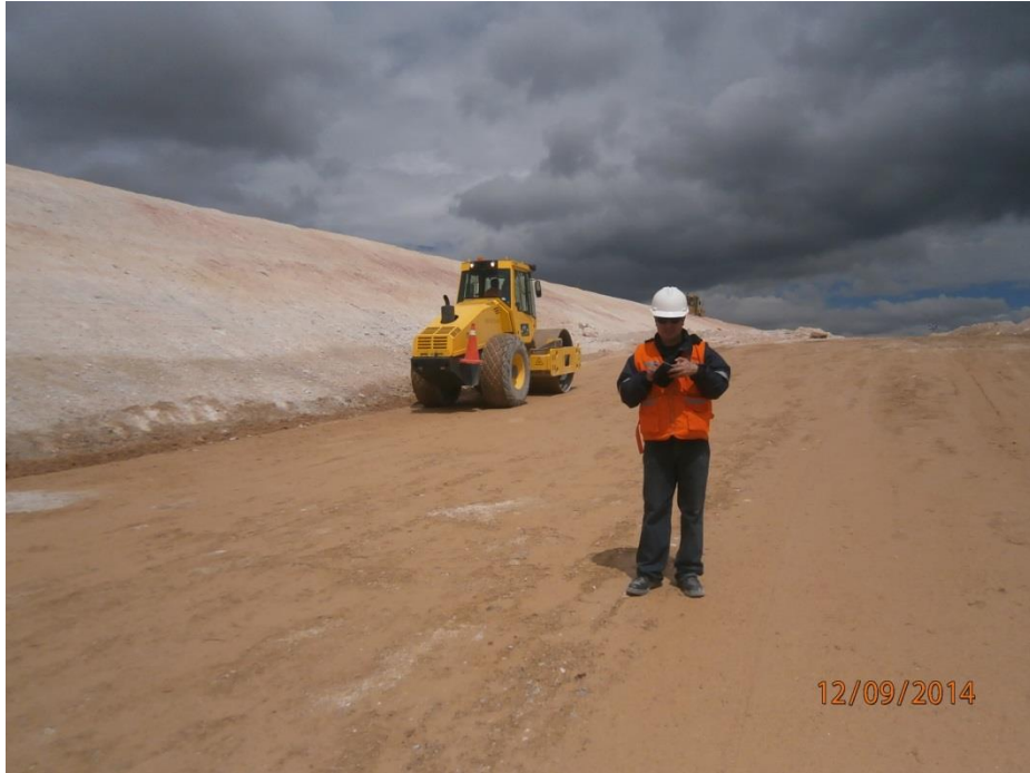
FOTO N°5: Compactación de capas de relleno común.
