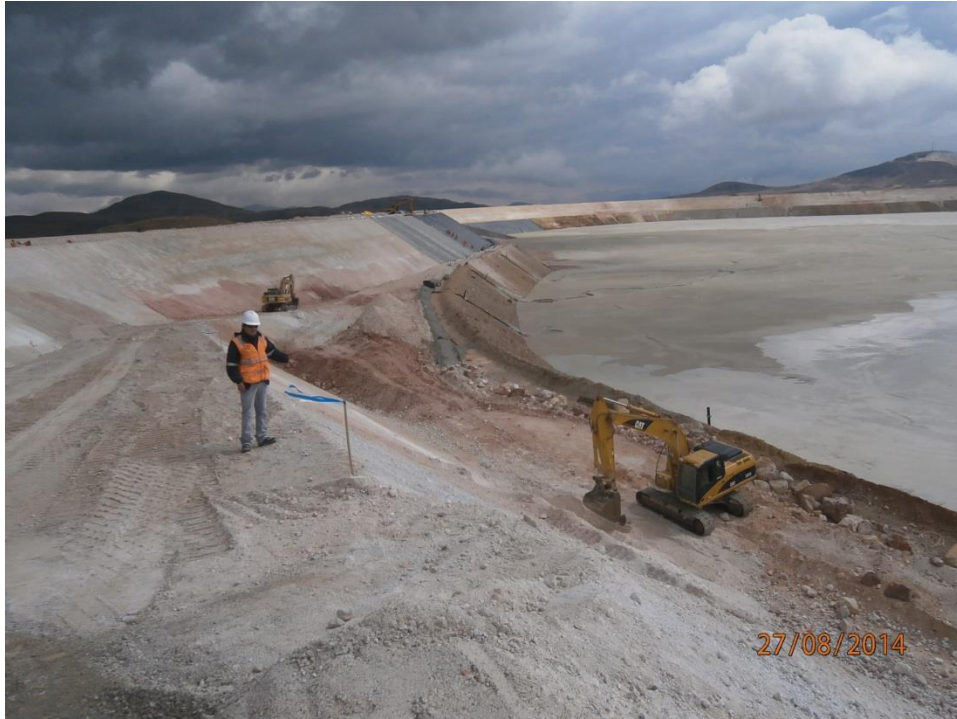
FOTO N°7: Trabajos de conformación y perfilado de talud
