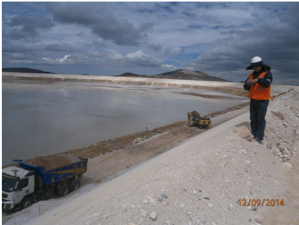
FOTO N°8: Verificación de trabajos de carguío de material (relleno común)
