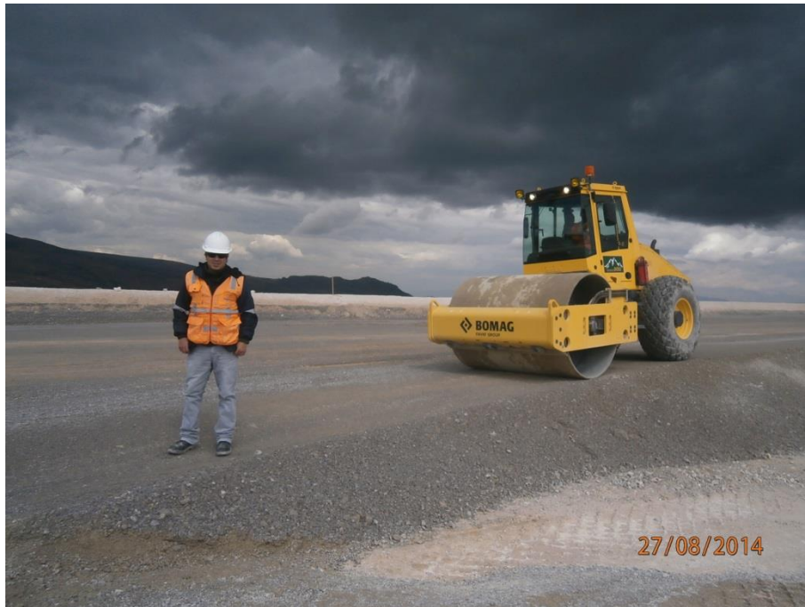
FOTO N°6: Compactación de capas de relleno común.
