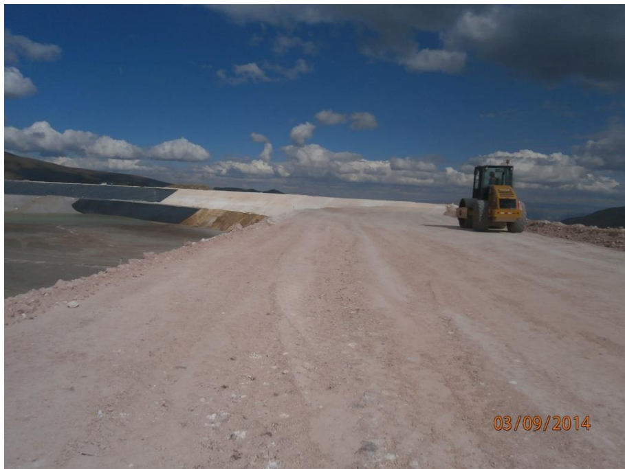
FOTO N°4: Compactación de capas de relleno común.
