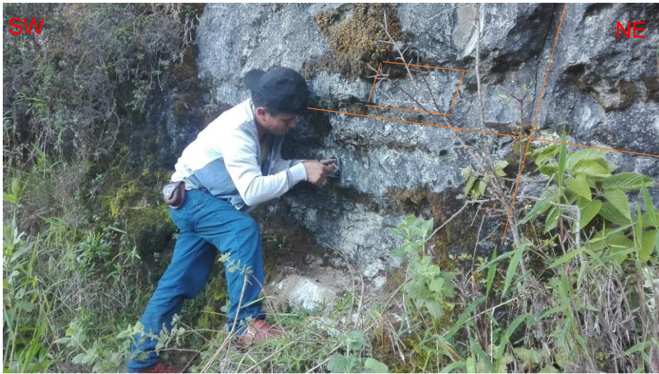
Foto 28: Macizo rocoso en la estación E-04.
