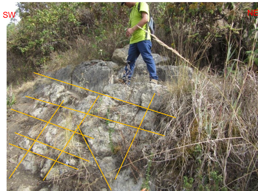
Foto 30: Macizo rocoso en la estación E-07.
