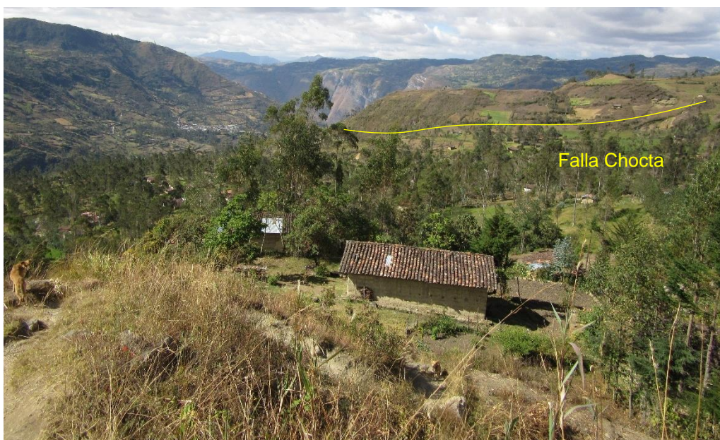
Foto 22: Ubicación falla Chocta.
