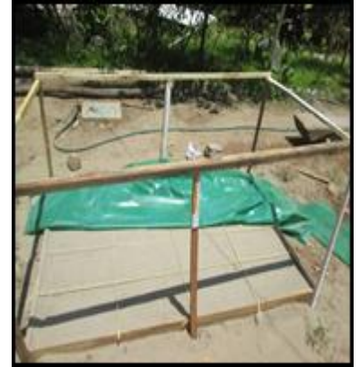
Foto 21. Construcción del tinglado del germinador
