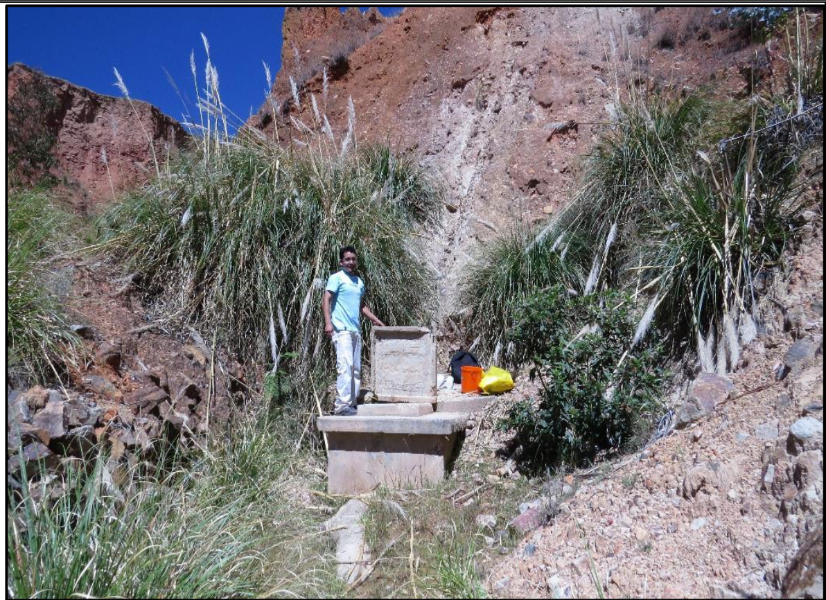
Figura 39. Infraestructura del manantial Chupiticaga
