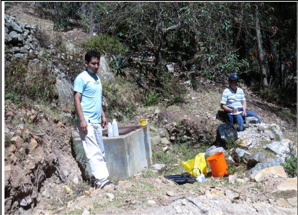
Figura 34. Infraestructura del manantial La Masma
