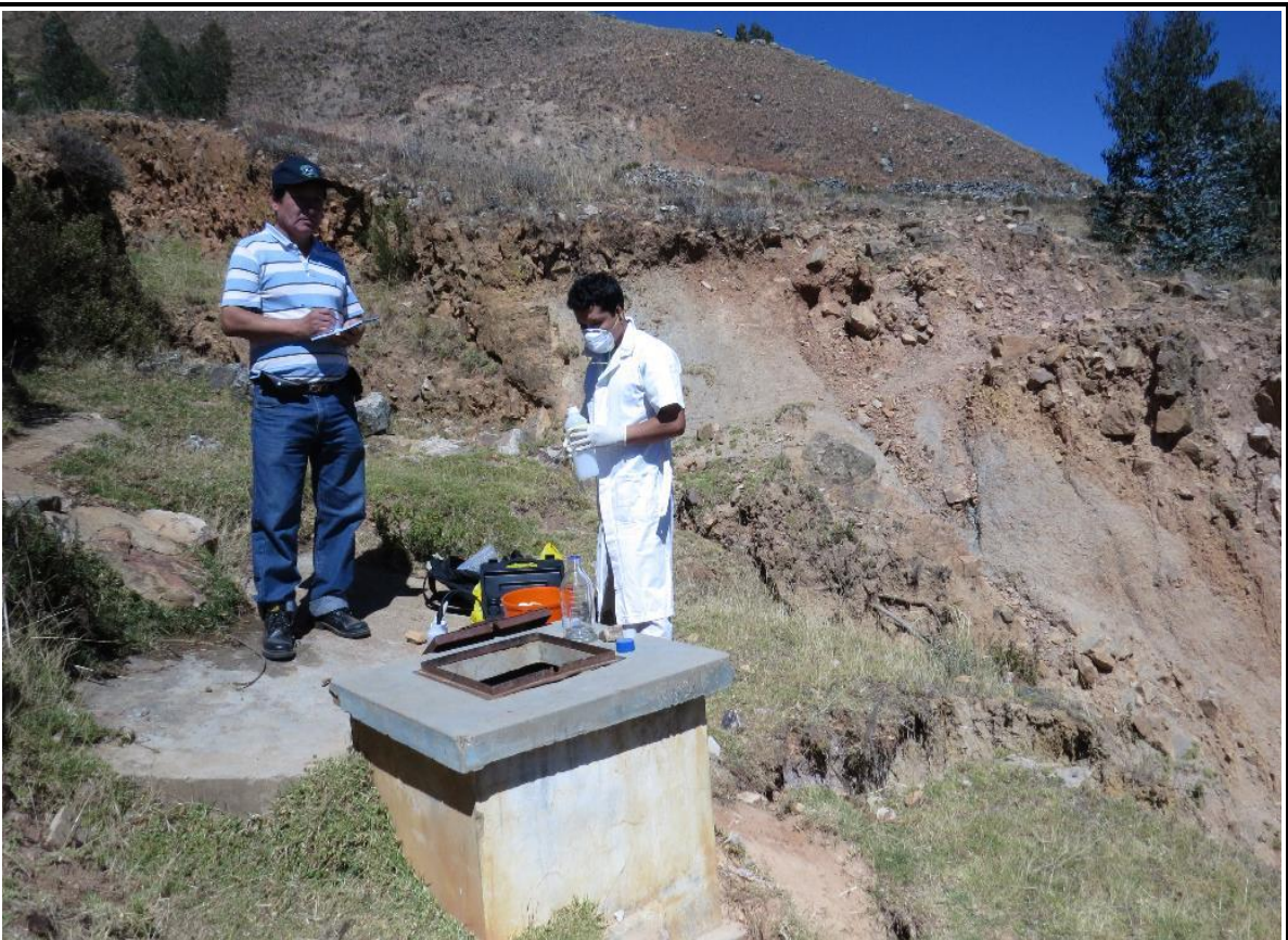
Figura 29. Infraestructura del manantial Ñoñorco
