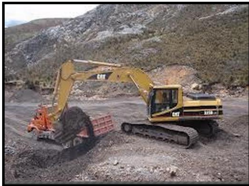
Foto 03 (Fase maniobra de carguío del cucharón excavadora)
