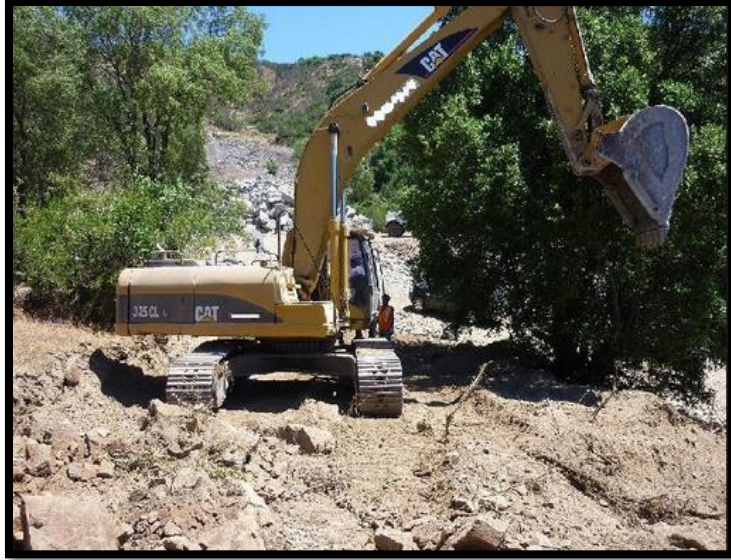
Foto 02 (Fase maniobra de carguío excavadora)
