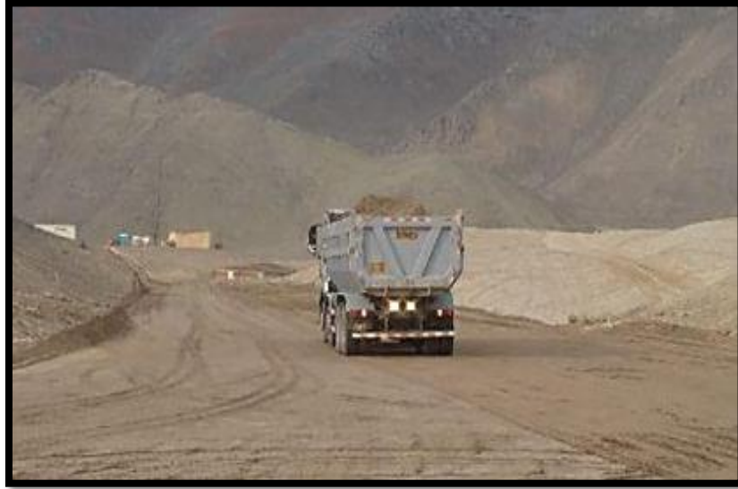
Foto 12 (Fase acarreo camión)
