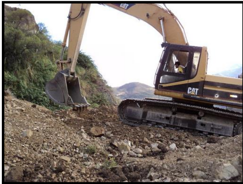
Foto 05 (Fase espera por camión excavadora)
