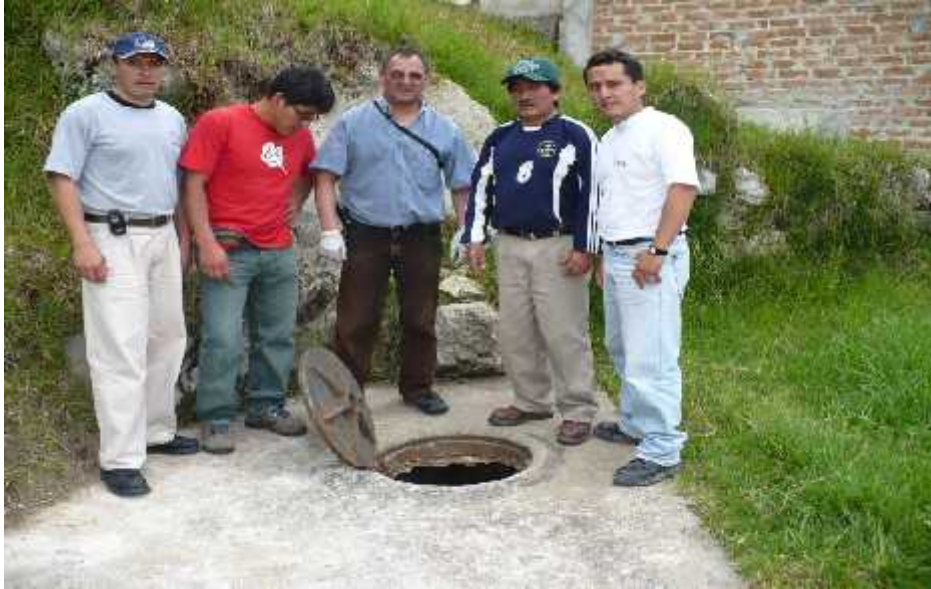
Figura 18. Tesista en compañía del personal de SEMACEL y DESA en la captación de Molinopampa.
