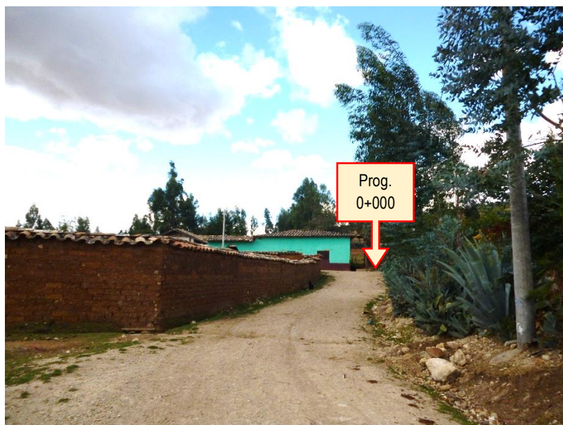
Fotografía N° 02. Vista general del cruce Pachilanga – Cauday, la misma que define la progresiva de inicio Km 0+000.
