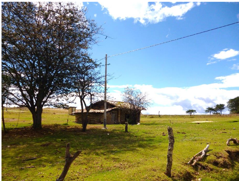
Fotografía N° 05. Ubicación de vivienda beneficiada por el proyecto. Se observa que cuenta con servicio de Electrificación.
