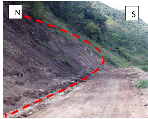
Foto 2. Depósito Coluvio-Aluvial en el corte del acceso aguas arriba de la presa.
