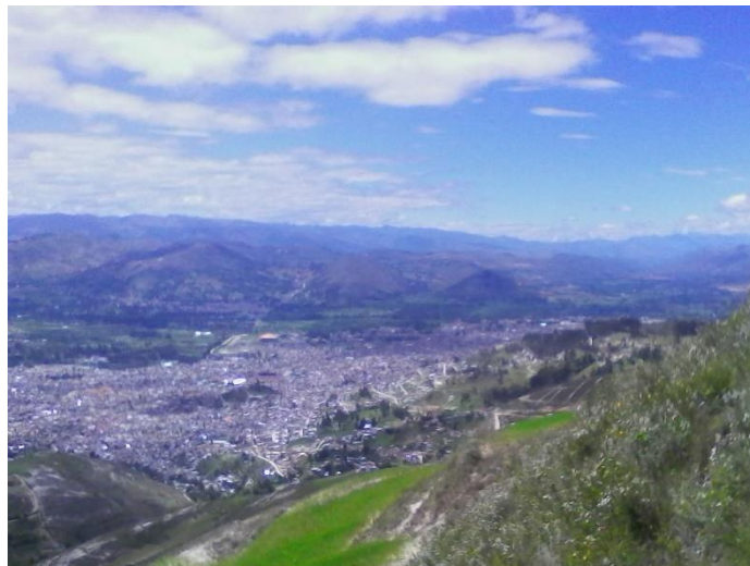
Figura 25. Talud de Urubamba, al fondo la ciudad de Cajamarca
