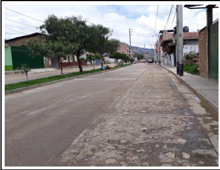
Figura 4: Pavimentación del Jr. Túpac Amaru (entre la Av. Heroes del Cenepa y el Jr. Arcomayo) – SNIP 38040
