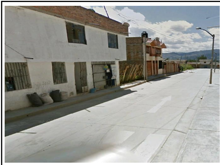
Figura 8: Mejoramiento de la infraestructura vial de las calles de la Asoc. de Vivienda Luis Alberto Sanchez – SNIP 37633. Vista de la Calle Basilio Cortegana.
