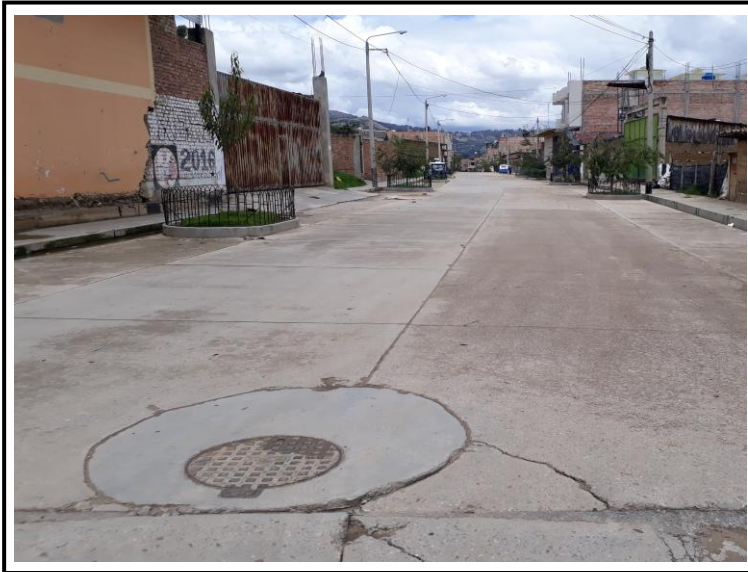
Figura 10: Construcción de la red de alcantarillado del Jr. Fernando Belaunde Terry (entre la Av. Heroes del Cenepa y el Jr. Jerusalén) – SNIP 171139.
