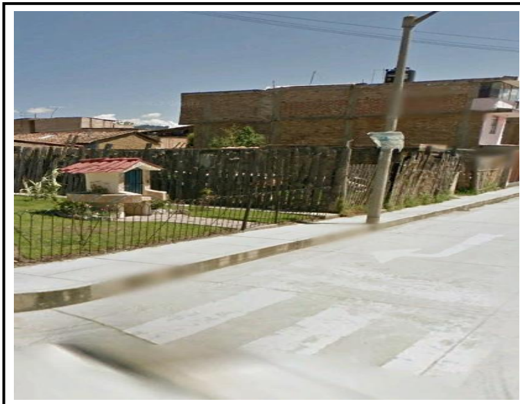
Figura 5: Mejoramiento de la infraestructura vial de las calles de la Asoc. de Vivienda Luis Alberto Sánchez – SNIP 37633. Vista del Jr. Larry Jhonson.
