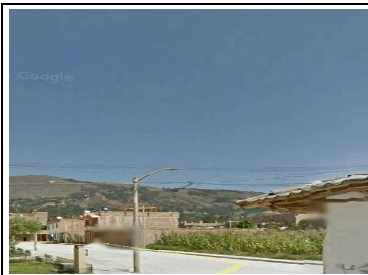
Figura 6: Mejoramiento de la infraestructura vial de las calles de la Asoc. de Vivienda Luis Alberto Sanchez – SNIP 37633. Vista de la Calle Las Magnolias.
