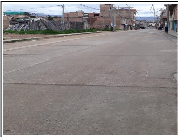
Figura 14: Pavimentación del Jr. San Isidro (entre la Av. San Martín y Jr. Beato MAsias) – SNIP 146392.
