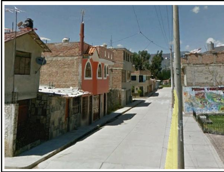
Figura 7: Mejoramiento de la infraestructura vial de las calles de la Asoc. de Vivienda Luis Alberto Sanchez – SNIP 37633. Vista de la Calle Virgen Del Sol.
