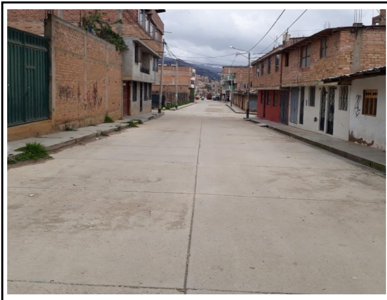
Figura 13: Pavimentación del Jr. Barrantes Lingan y tramo del Psje. Sin Nombre (entre la Avenida Jesús de Nazareth y la Avenida Tahuantinsuyo) – SNIP 161288.
