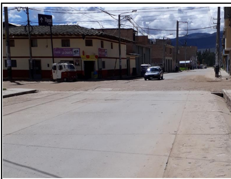
Figura 18: Pavimentación del Jr. Mártires de Uchuracay (entre la Av. Industrial y Vía Arterial) – SNIP 133581.
