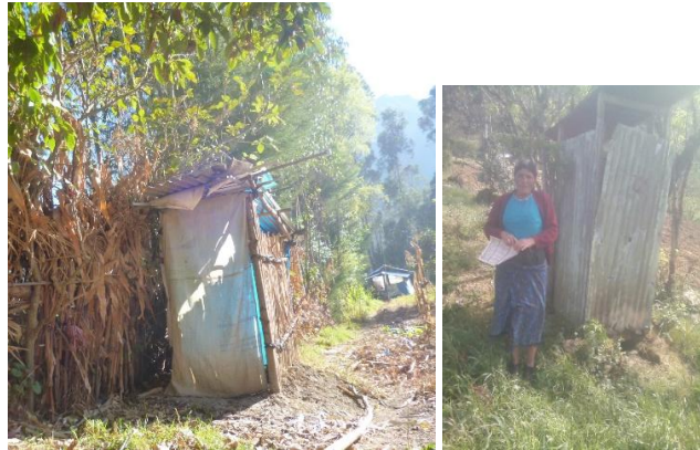
Fig. 04. Pozo séptico Chicolon Bajo
