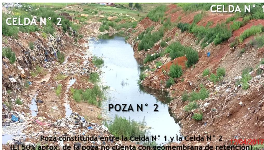
Figura 1: Unidad de análisis del peligro de lixiviados en la PTRS Cajamarca
