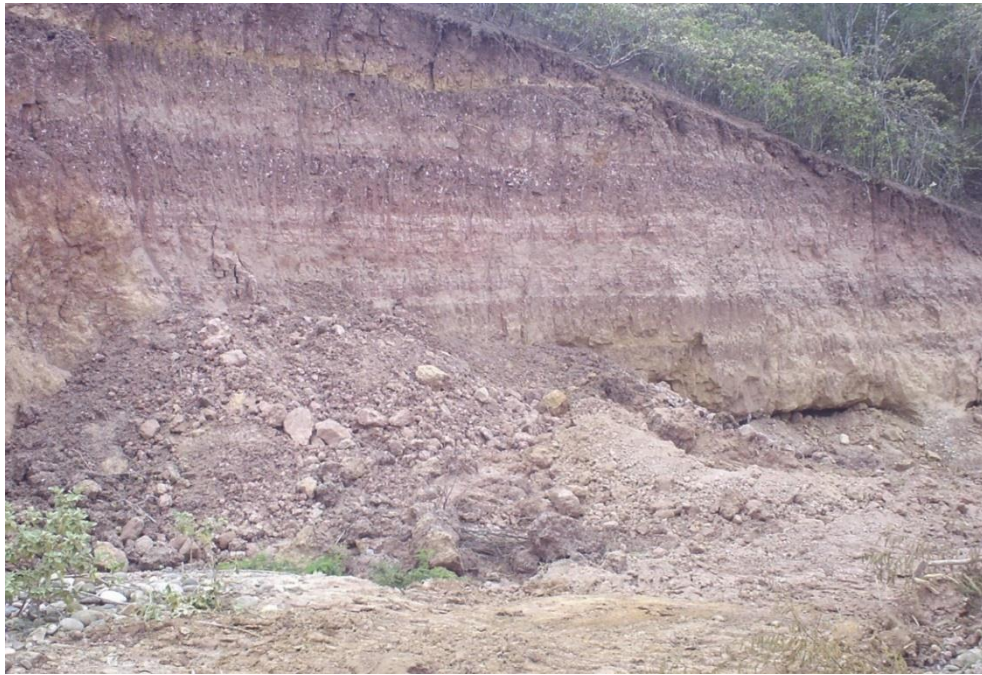
Figura 3. Cargador frontal en el proceso de corte de talud sobre la secuencia el Milagro
