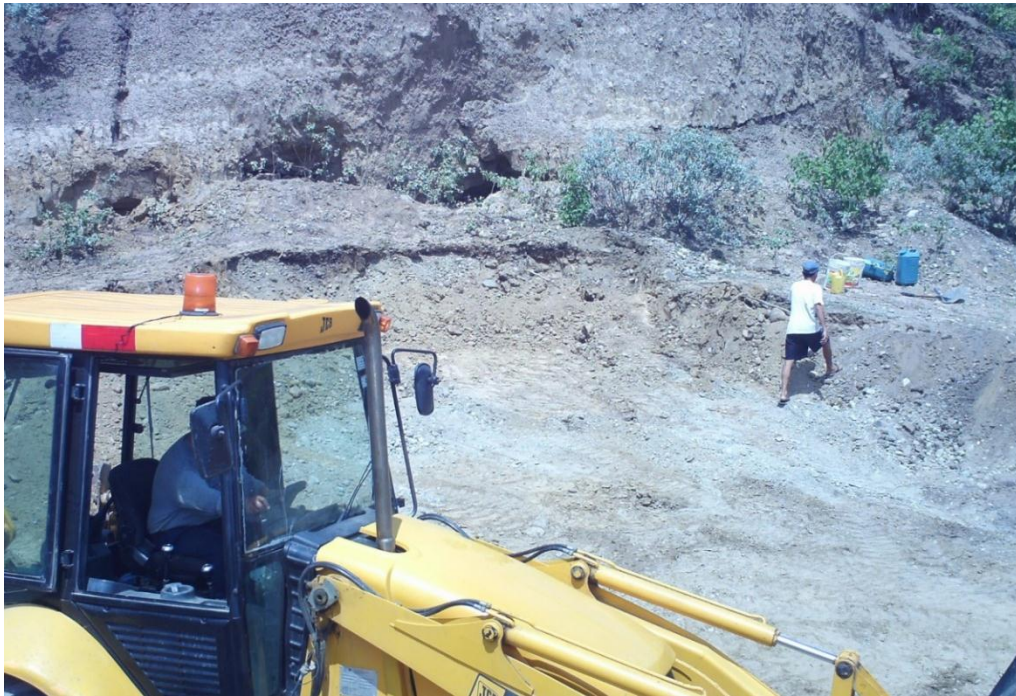
Figura 5. Calicata inicial en la secuencia de la arena aurífera aluvial
