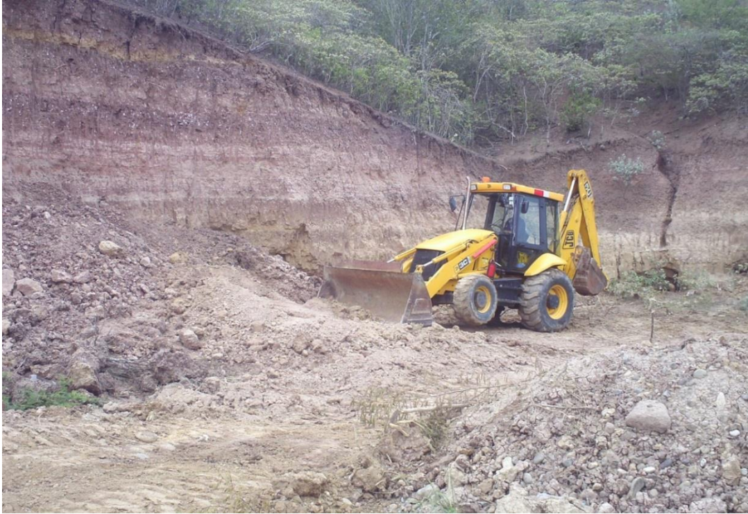
Figura 4. Se observa el lado oeste del plan piloto del sistema de lavado
