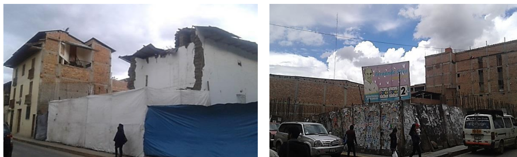
Figura 55: Casonas demolidas, ubicadas a la derecha en las calles del Jr. Junín con Jr. Dos de Mayo y a la izquierda en el Jr. Tarapacá con el Jr. Amazonas, del centro histórico de Cajamarca.
