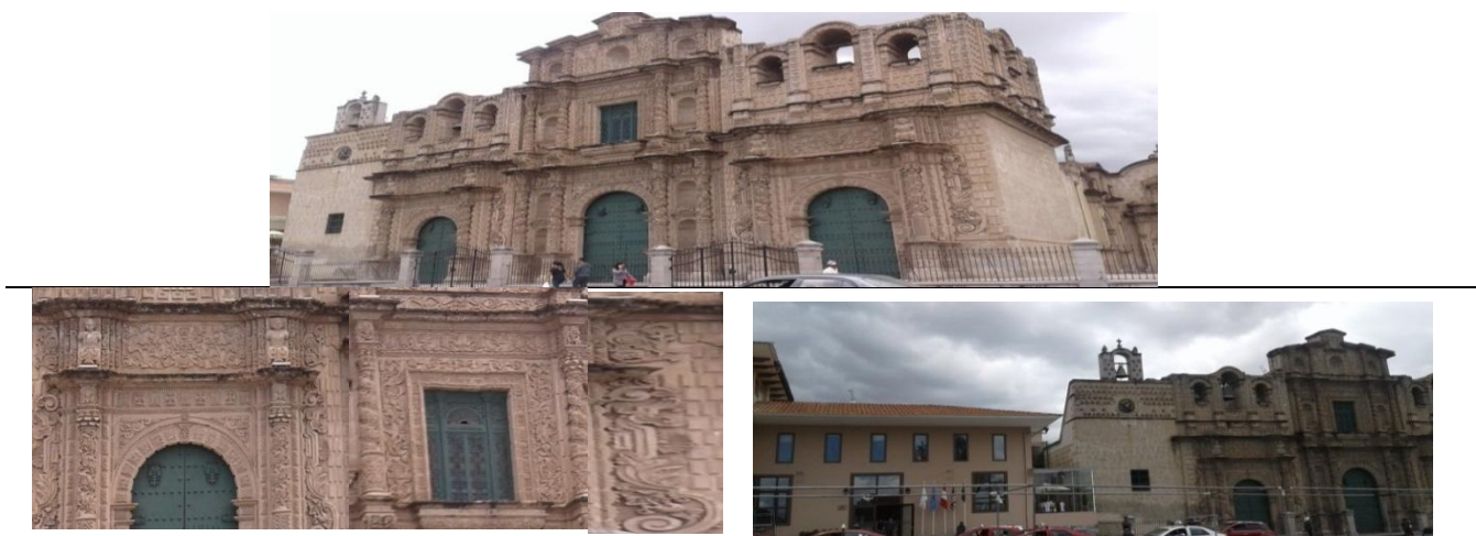
Fachada Iglesia La Catedral -2015
