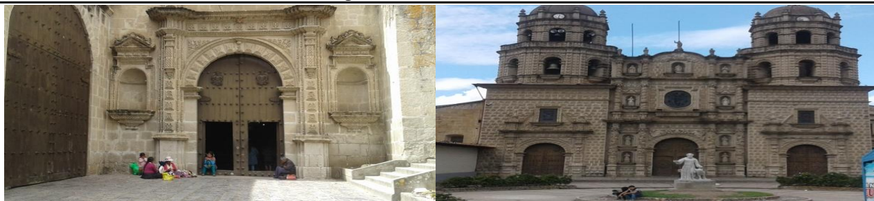
Fachada de la iglesia San Francisco-2015
