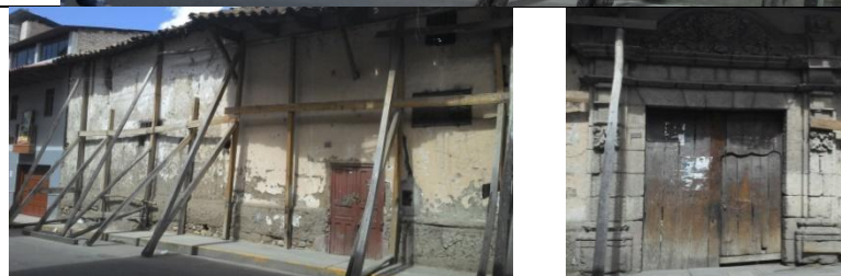
Fachada casona Toribio Casanova- 2015
