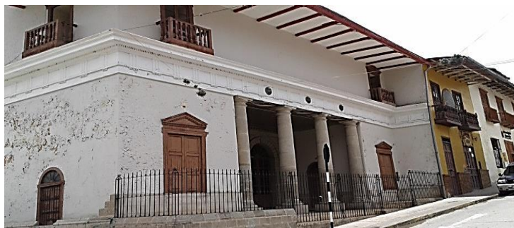
Figura 87: Fotografía fachada del Teatro Cajamarca, 2016.
