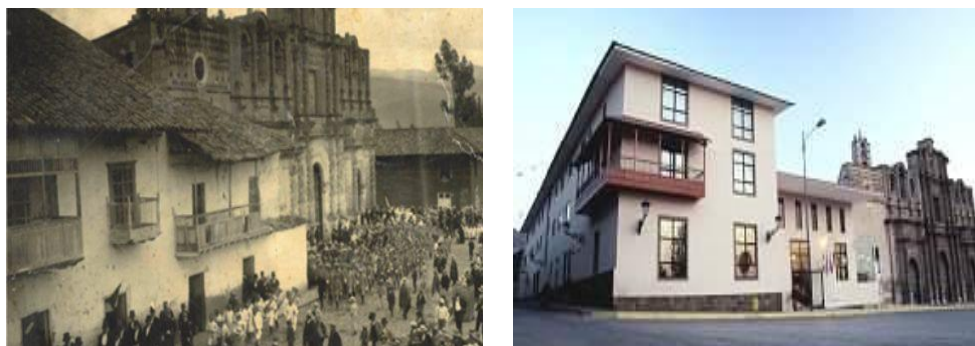
Figura 96: A la derecha antiguo hotel de Turistas y a la izquierda Hotel Costas del Sol, junto a la Iglesia Santa Catalina- La Catedral, ubicado en la Plaza de Armas de la ciudad Cajamarca.2015
