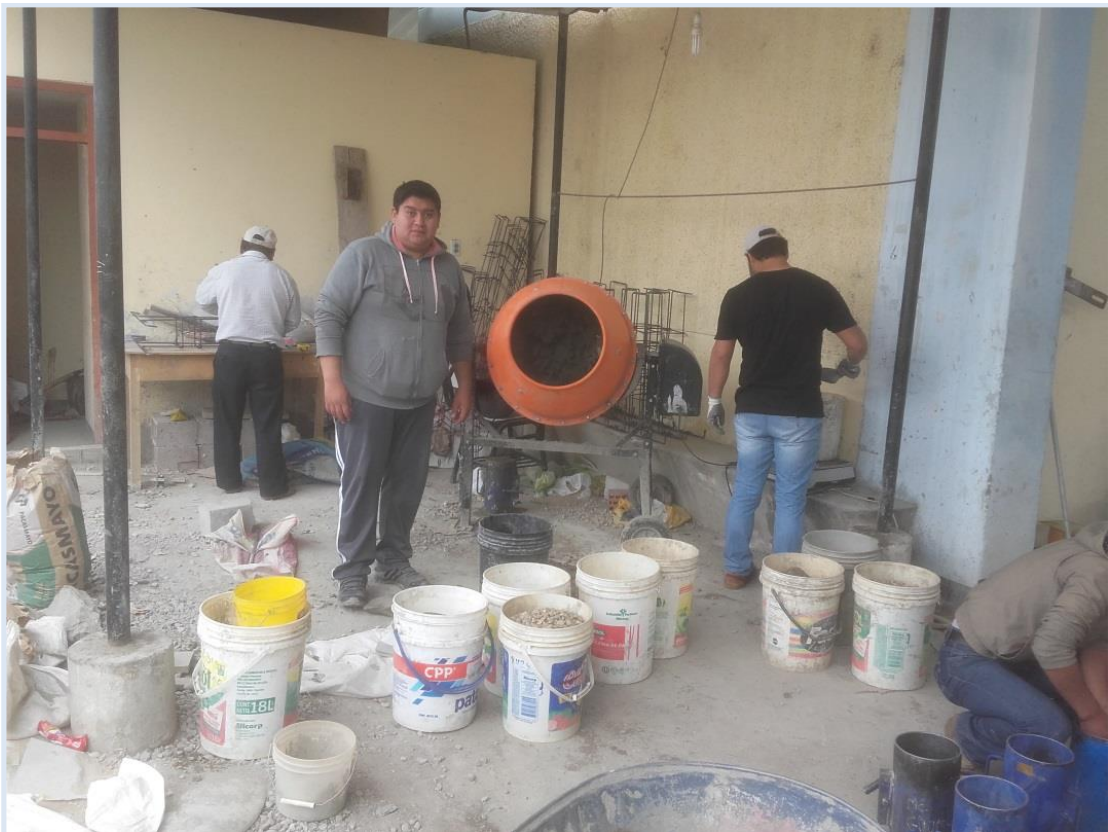
Figura 30. Materiales para la elaboración de la mezcla
