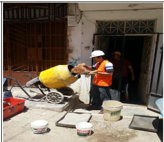
Foto N° 12 Materiales pesados y se procedió con la colocación de la fibra vegetal (cocos nocifera) al trompo.
