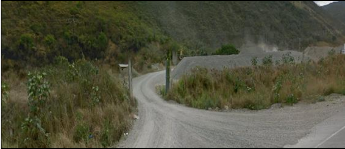
Figura N° 16 “Cantera Olano” donde se obtuvo los agregados.
