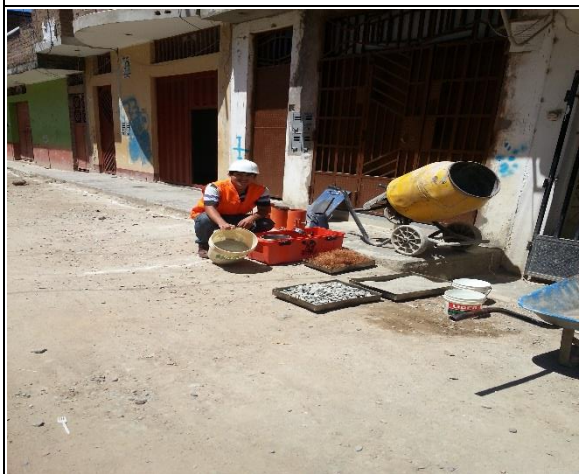
Foto N° 12 Materiales pesados y se procedió con la colocación de la fibra vegetal (cocos nocifera) al trompo.
