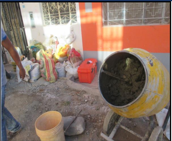
FOTO 19: Pesado de los componentes de la mezcla y mezclado de la tanda
