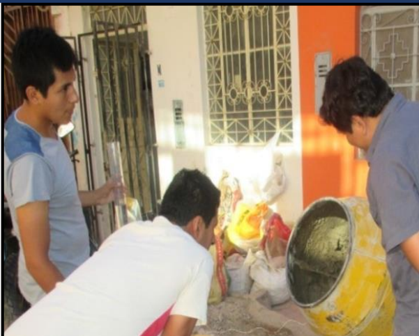
FOTO 19: Pesado de los componentes de la mezcla y mezclado de la tanda
