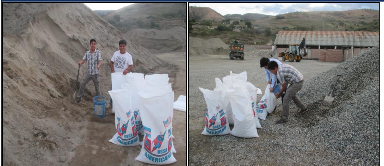
FOTO 1: Elección y acarreo de los agregados de la cantera "Olano"
