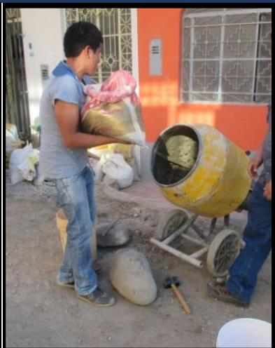
FOTO 18: Pesado de los componentes de la mezcla y mezclado de la tanda
