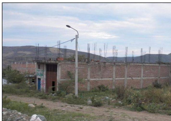
Fig. N° 04: En la imagen se muestra la vivienda construida ser Analizada.
