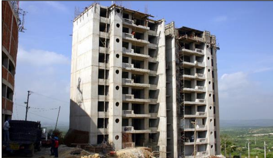
Fig. N° 14: Proceso constructivo de un Edificio de un sistema Dual.
