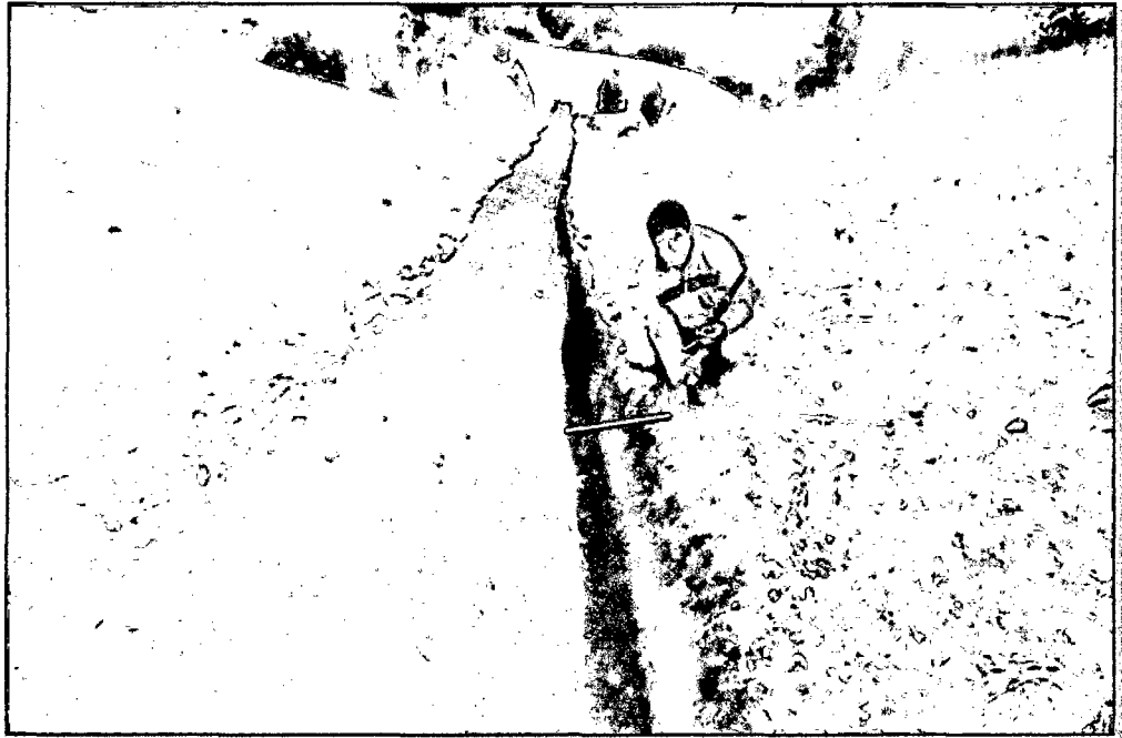
Fotografía N° 10. Excavación de zanjas para las redes de distribución, actividad realizada en forma grupal, se cuenta con una cuadrilla de 10 peones.
