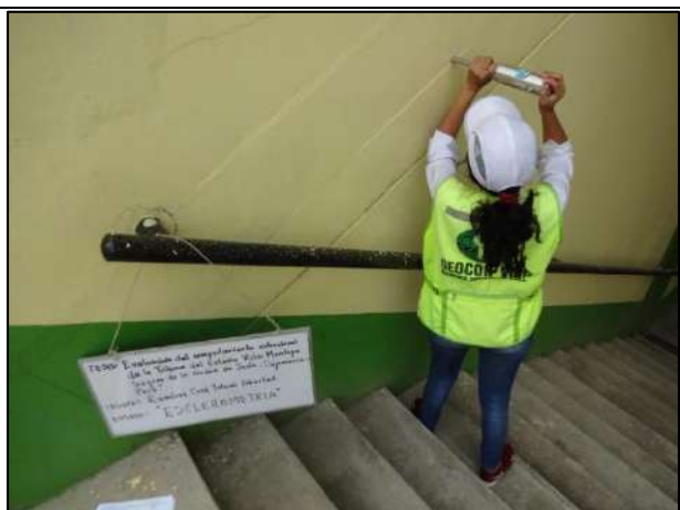
Fotografía N° 18: Realización del ensayo con "Esclerómetro" – Vigas.
