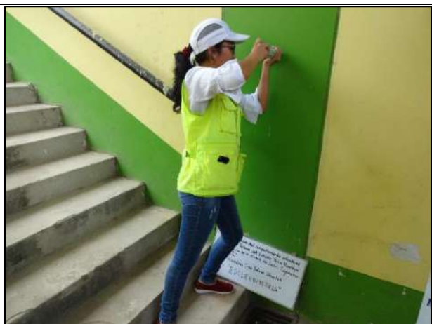
Fotografía N° 16: Realización del ensayo con "Esclerómetro" – Columnas.
