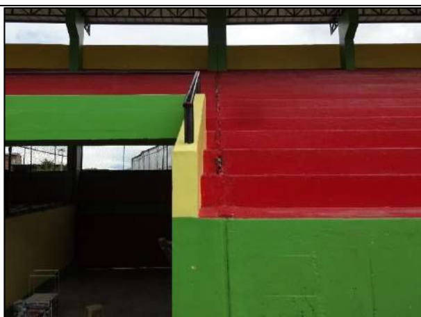
Fotografía N° 03: Se aprecia la junta de dilatación entre columnas de la Tribuna Oriente del estadio “Víctor Montoya Segura”.
