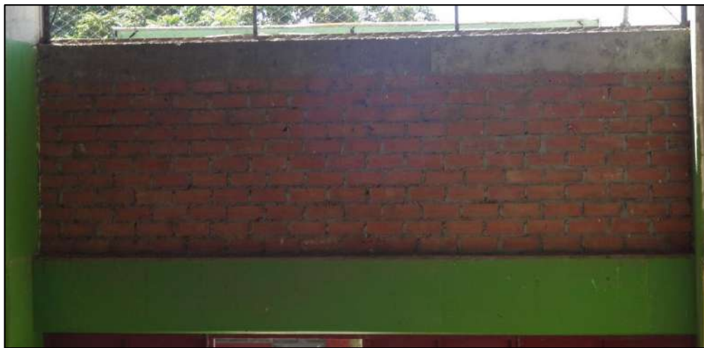
Figura N° 32: Fotografía Parapeto de ladrillo King Kong artesanal.
