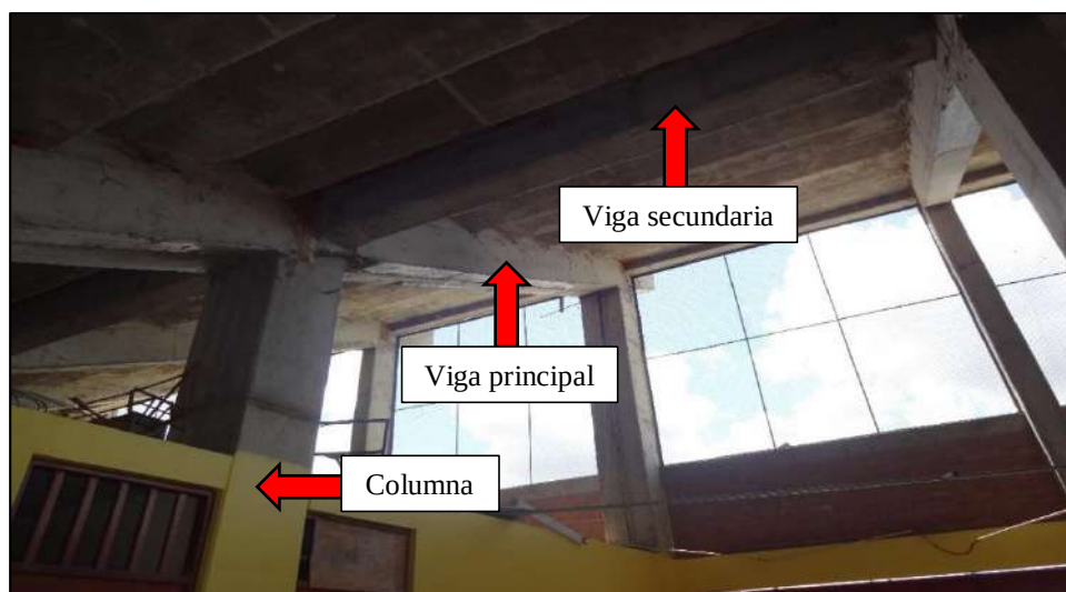
Figura N° 27: Pórtico de la Tribuna Oriente Estadio “V́ctor Montoya Segura”. Fuente: Elaboraci3n propia.
