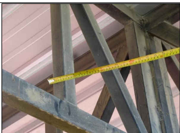
Fotografía N° 06: Toma de medidas del tijeral del Techo Metálico de la Tribuna Oriente del estadio “Víctor Montoya Segura”.
