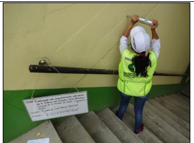
Fotografía N° 18: Realización del ensayo con “Esclerómetro” – Vigas.
