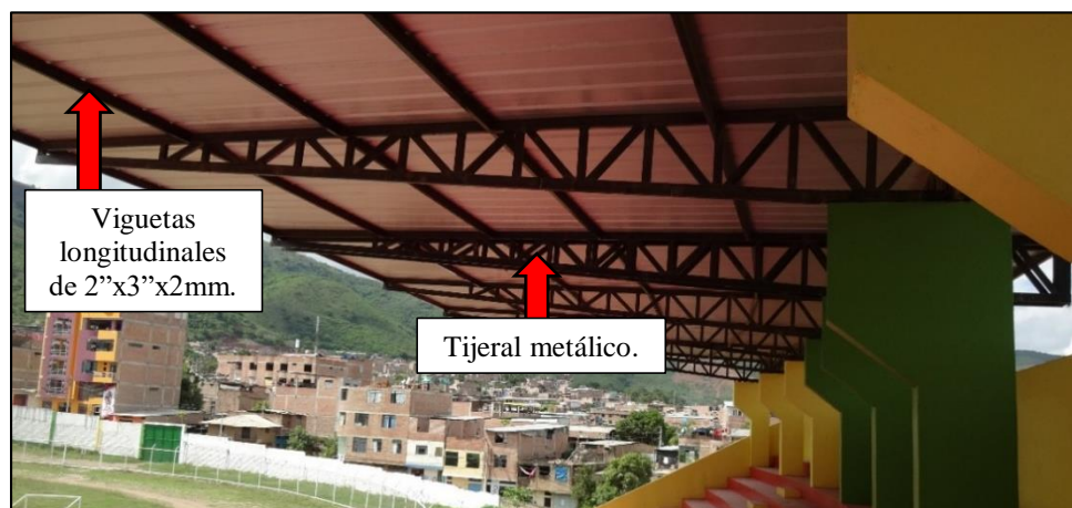
Figura N° 30: Tijerales Metálicos – Techo metálico Tribuna Oriente. Fuente: Elaboración propia.
