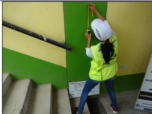
Fotografía N° 15: Toma de medidas para la realización del ensayo con “Esclerómetro” – Columnas.
