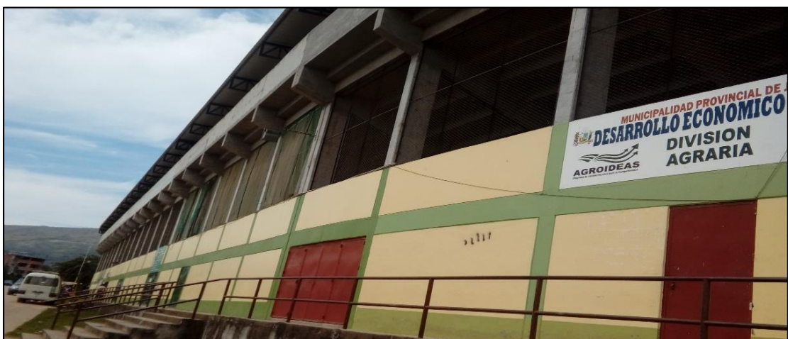
Figura N° 23: Tribuna Oriente Estadio “Víctor Montoya Segura” – Vista posterior. Fuente: Elaboración propia.
