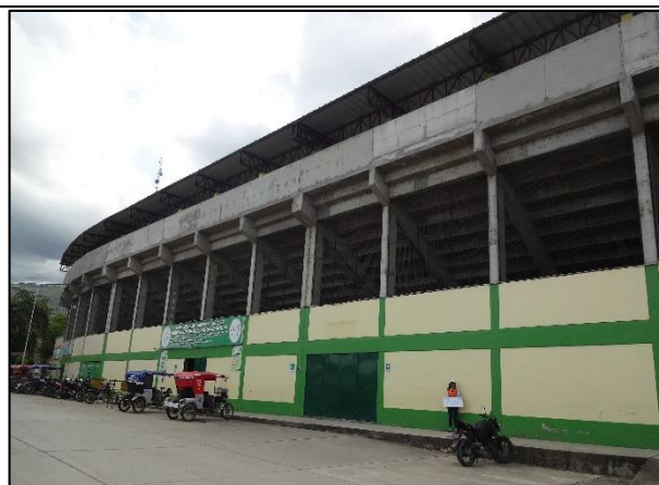
Fotografía N° 02: Vista posterior de la Tribuna Oriente del estadio “Víctor Montoya Segura”.
