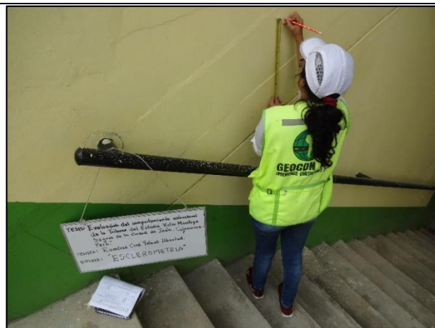
Fotografía N° 17: Toma de medidas para la realización del ensayo con “Esclerómetro” – Vigas.
