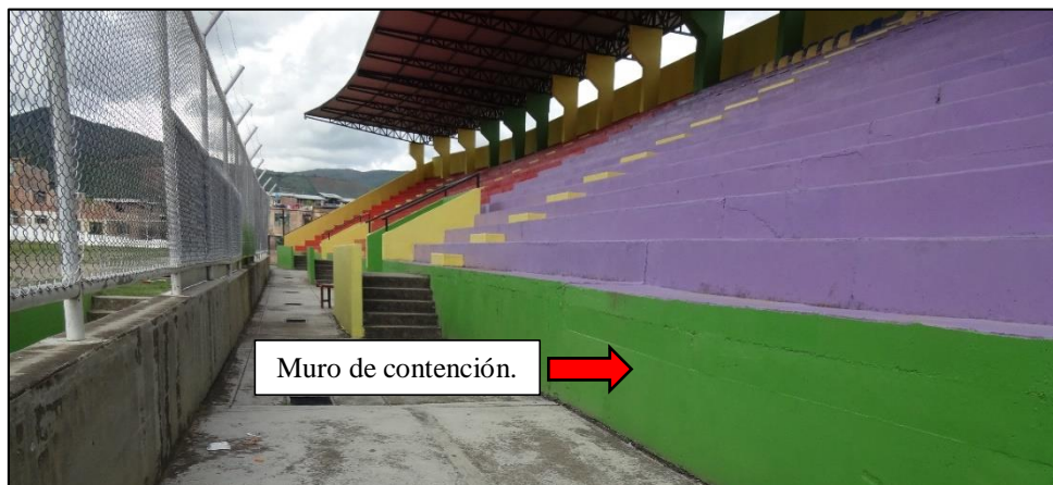
Figura N° 29: Muro de contención - Tribuna Oriente Estadio "Víctor Montoya Segura". Fuente: Elaboración propia.
