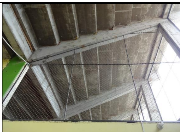
Fotografía N° 05: Se aprecia las vigas y columnas que conforman la Tribuna Oriente del estadio “Víctor Montoya Segura”.
