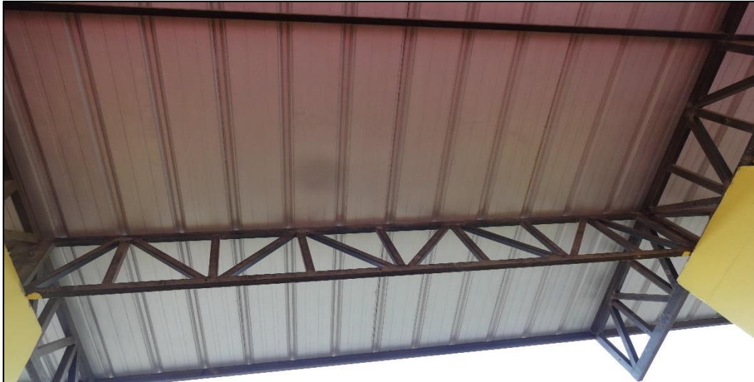
Figura N° 35: Fotografía del techo metálico con cobertura liviana. Fuente: Elaboración propia.
