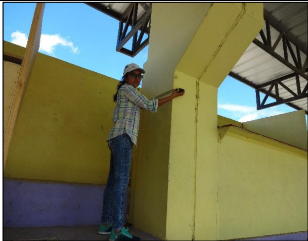
Fotografía N° 09: Toma de medidas de las columnas de la Tribuna Oriente del estadio "Victor Montoya Segura".
