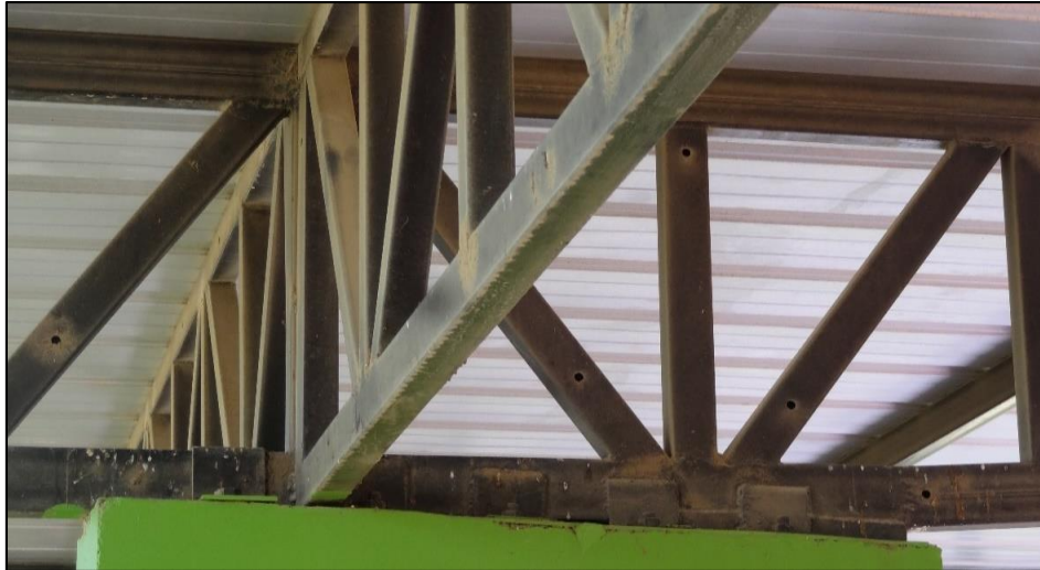
Figura N° 33: Fotografía del tijeral metálico – Techo Metálico. Fuente: Elaboración propia.
