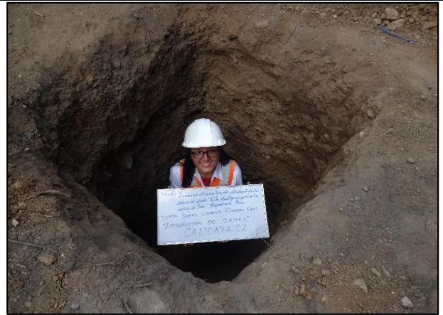
Fotografía N° 22: Calicata N° 02 – Margen derecha de la Tribuna Oriente del estadio.
