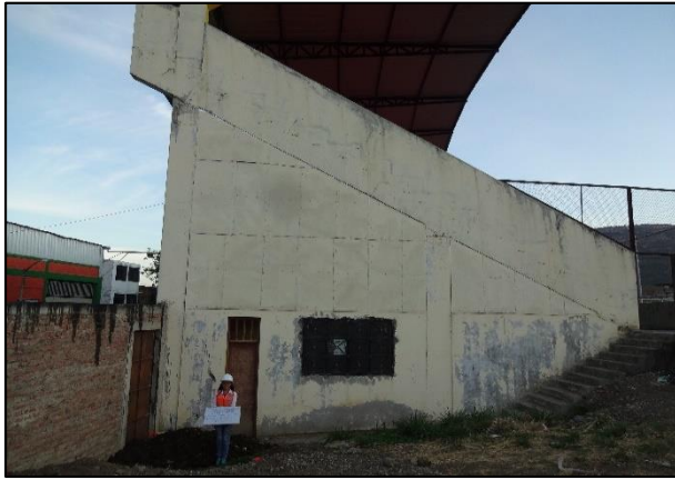
Fotografía N° 19: Excavación de la calicata N° 01 – Margen izquierda de la Tribuna Oriente.
