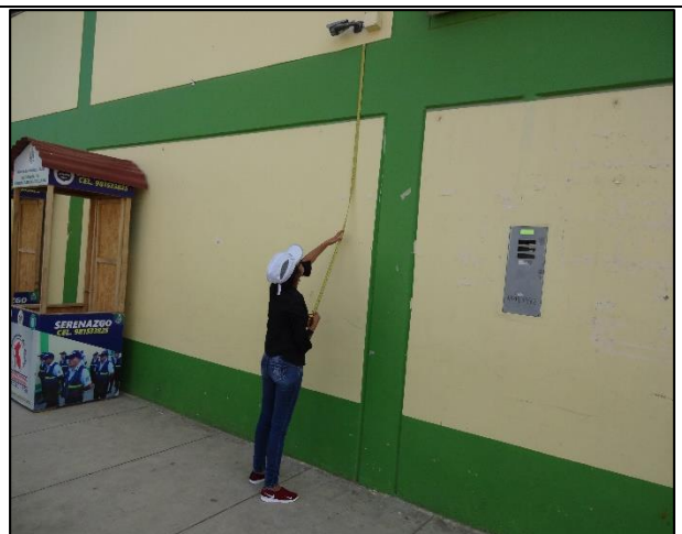
Fotografía N° 12: Toma de medidas de las vigas de la Tribuna Oriente del estadio "Victor Montoya Segura".
