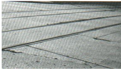
Figura 41. Cruce de vía férrea de baja severidad.
