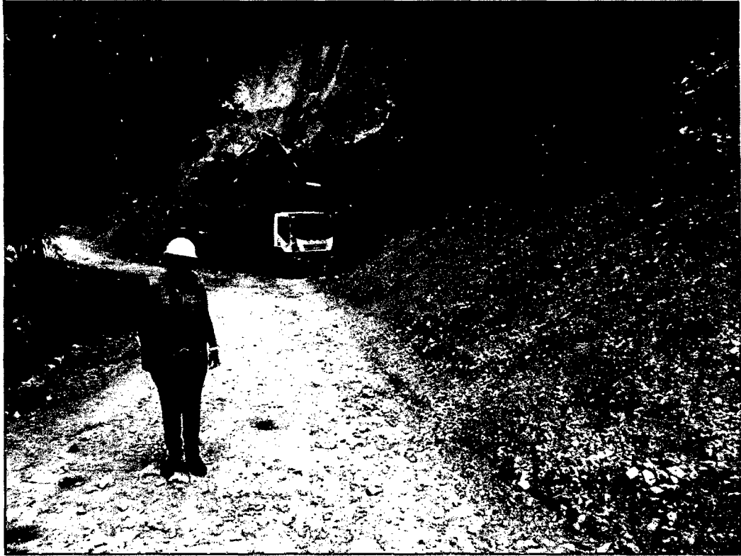
FOTOGRAFÍA 3. MAQUINARIA PESADA TRABAJANDO SIN SEGURIDAD VIAL.
