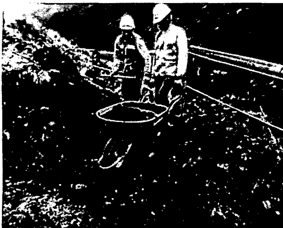
Foto N°3: Carguío de Topsoil
