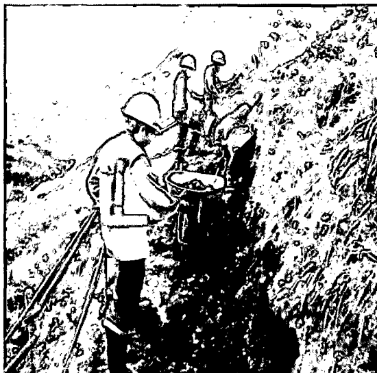
FotoN°2: Carguío de topsoil
