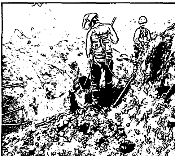
Foto N°3: Excavación en roca suelta
