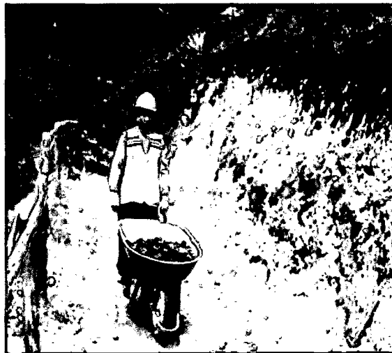
Foto N°4: Eliminación de material excedente
