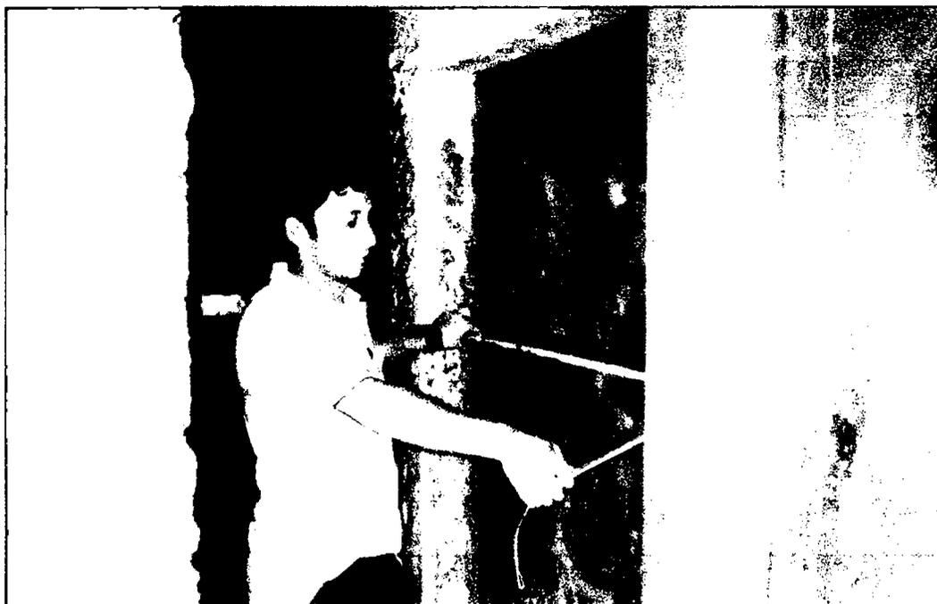
Figura N°6. Tomando medidas del ancho del tarrajeo en muros interiores del hostel
