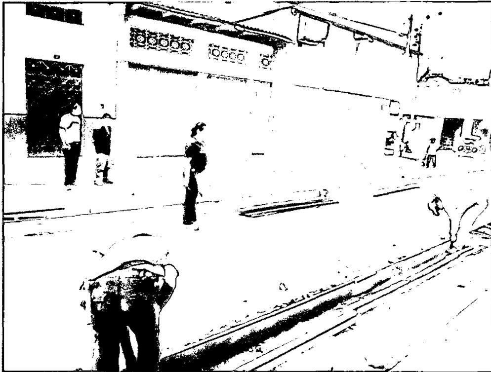
Figura A4. Encofrado para losas de concreto en calle Los Laureles cdra. 01- Sector Morro Solar
