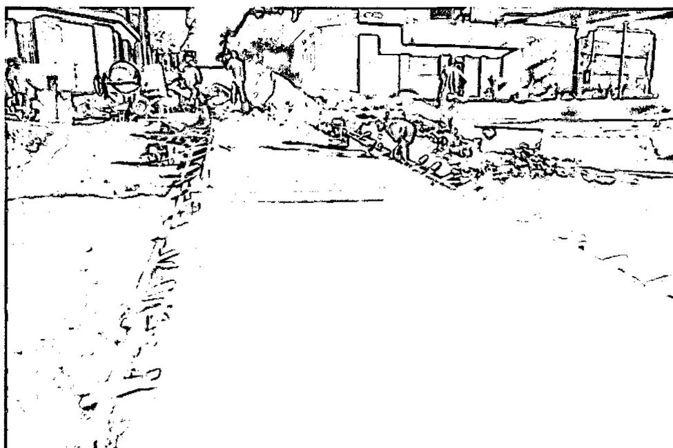
Figura A9. Vaciado de concreto de losas macizas en calle Prol. Manco
