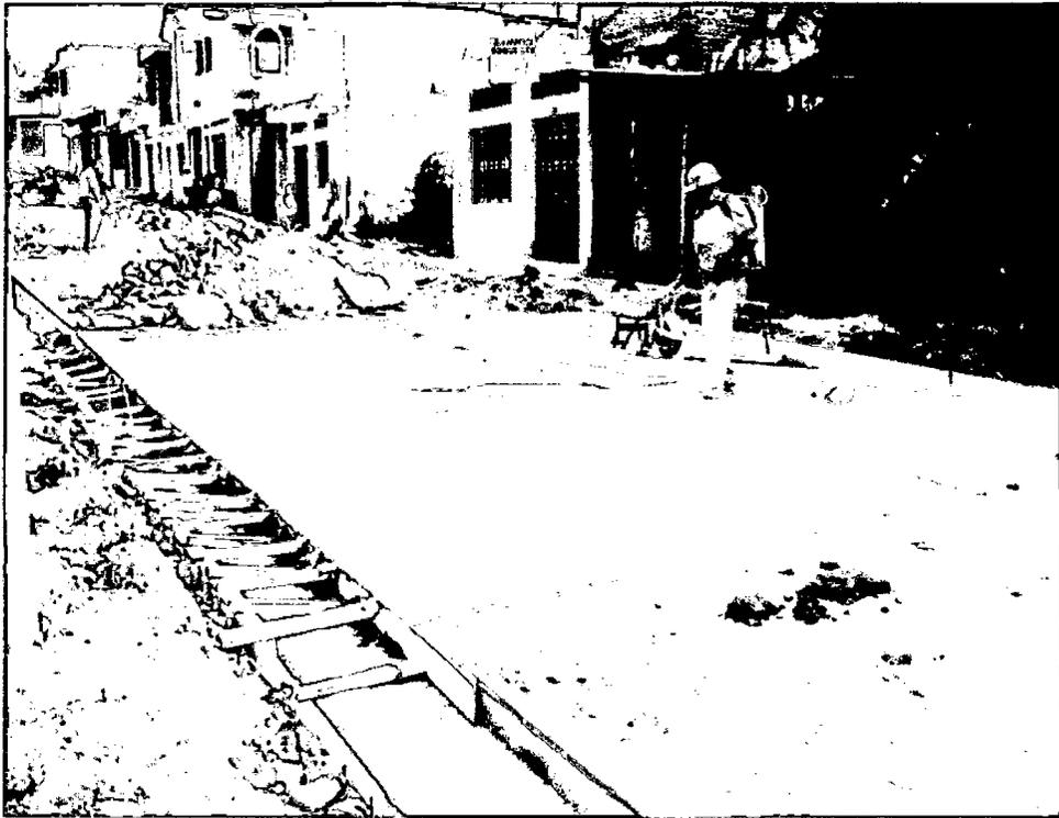
Figura A10. Curado de concreto con aditivo membranal C-9 en calle Prolongación Manco Capac cdra. 6 – sector Morro Solar
