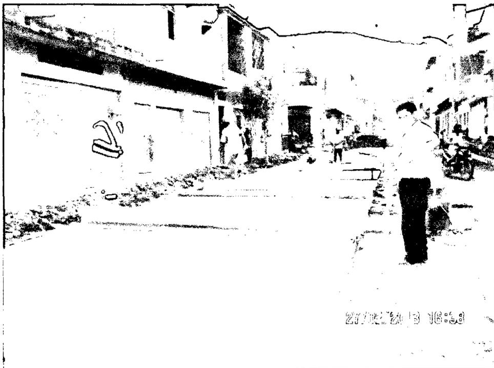
Figura A13. Curado de concreto con aditivo membranal C-9 en calle Alfredo Bastos cdra.03- sector Morro Solar
