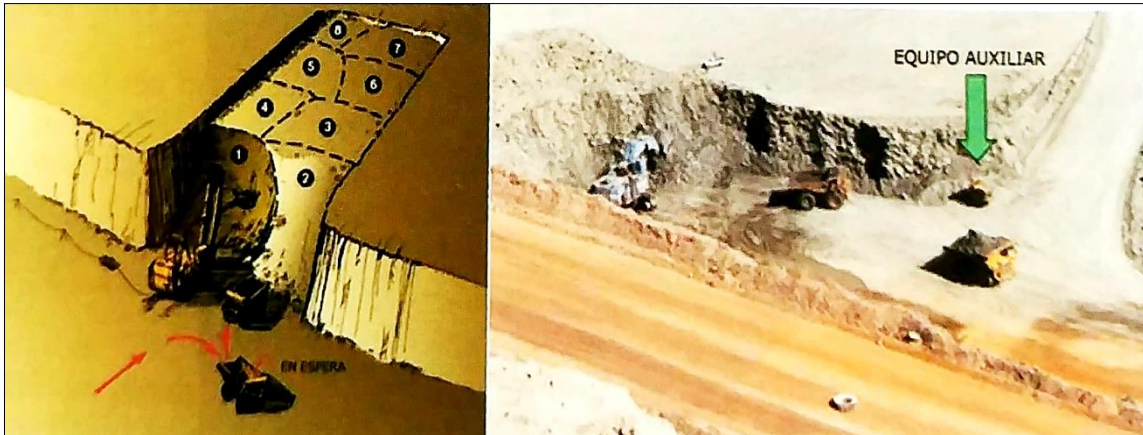
Figura 3. Carga con excavadora a un lado. (López et al, 2014, p.163)
