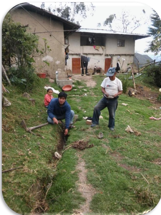
Fotografía 2: Instalación del medidor de agua doméstico en la vivienda N° 01
