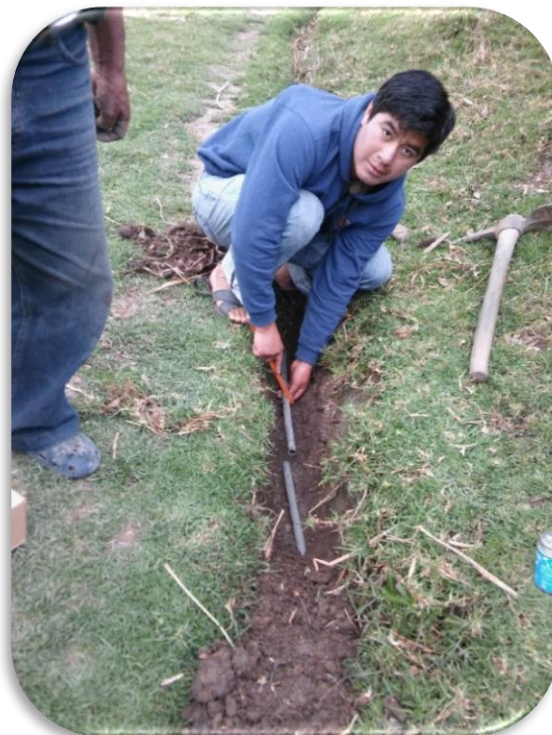
Fotografía 3: Instalación de medidor de agua N° 01, con presencia del tesista
