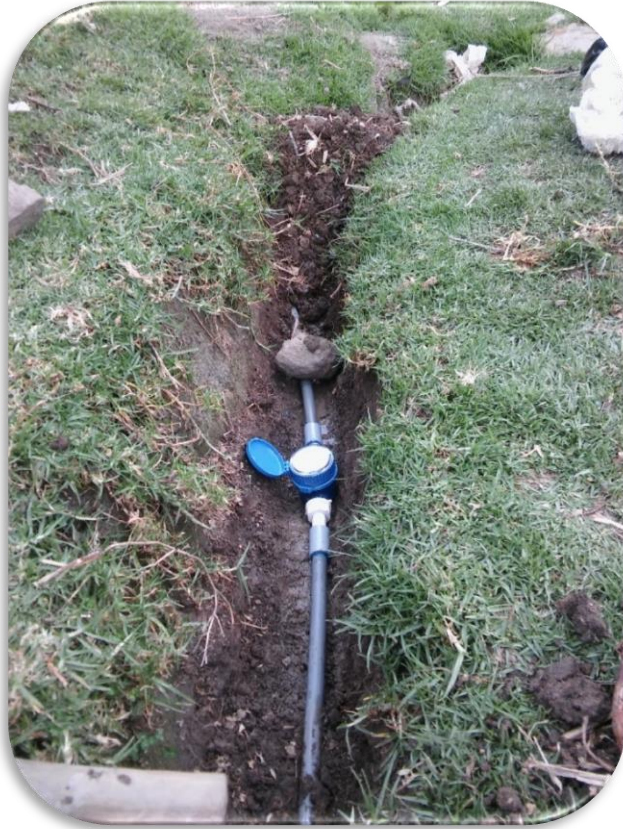
Fotografía 4: Medidor de agua doméstico N° 01 ya instalado
