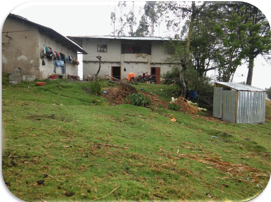
Fotografía 17: Vista general de la vivienda N° 01, donde se ubica SS-HH y pileta
