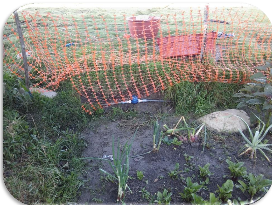
Fotografía 9: Vista general del medidor de agua doméstico N° 02
