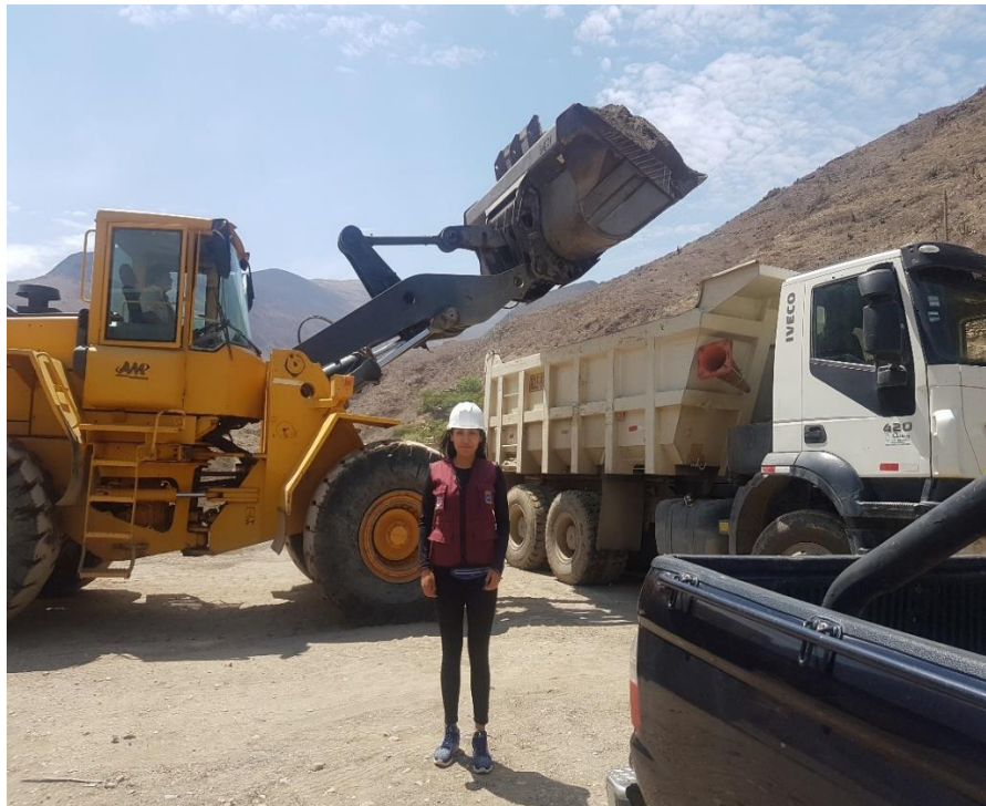
IMAGEN N°2: Fotografía de la carga de los agregados
