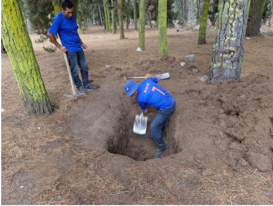
Figura 23. Apertura de calicatas
