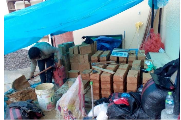
**Foto 23** : Elaboración de mortero para hacer muretes y especímenes del mortero a la tracción.
