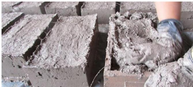
Figura 7: Enrazado de adobe reforzado con varillas de fibra de vidrio.
