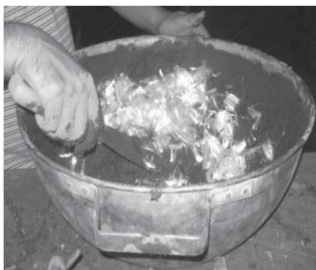
Figura 8: Preparación de la mezcla de adobe con incorporación de fibras.
