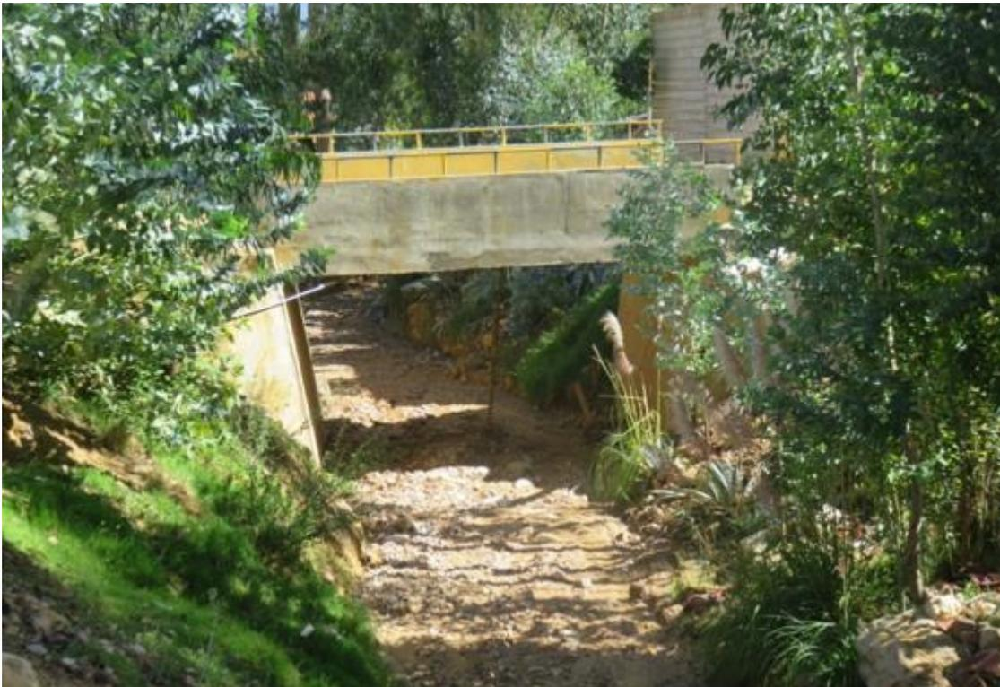
Figura 35. Puente de Agocucho, construido de concreto armado con una longitud de 7m, y una altitud de 3.50m.
