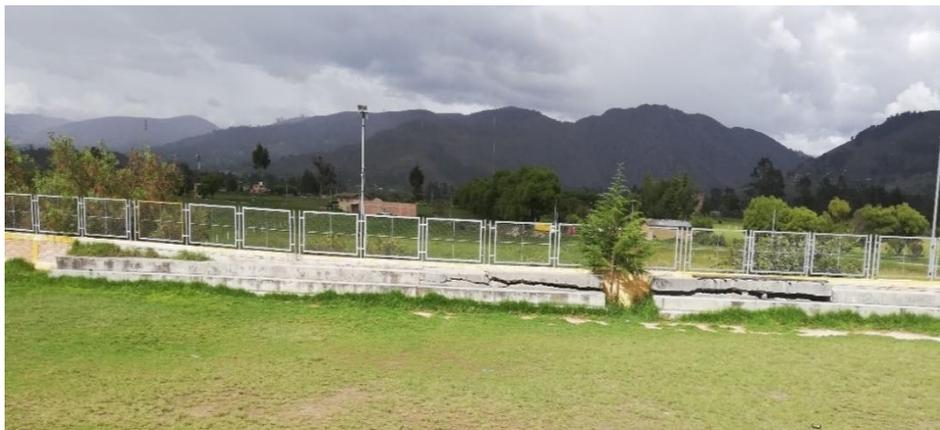
Figura 26. Asentamiento del terreno el cual produjo la ruptura de la estructura.
