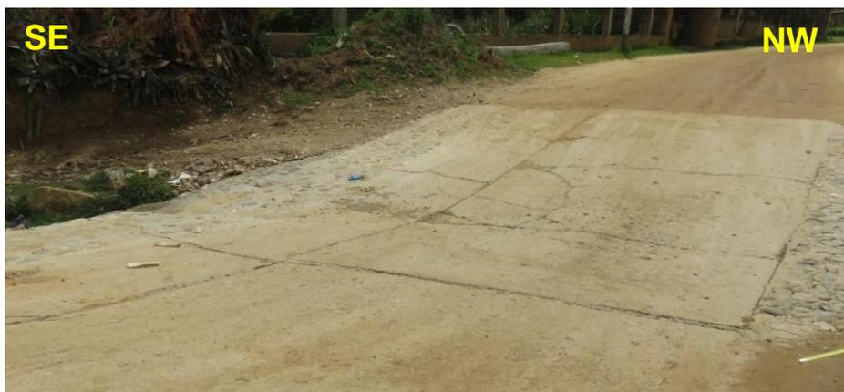
Figura 46. En la estación N°12 se halla la quebrada con orientación S20°W. Por donde pasa la quebrada te tenemos un badén de 70 cm de altura, y es badén ya que la profundidad de la quebrada es pequeña.
