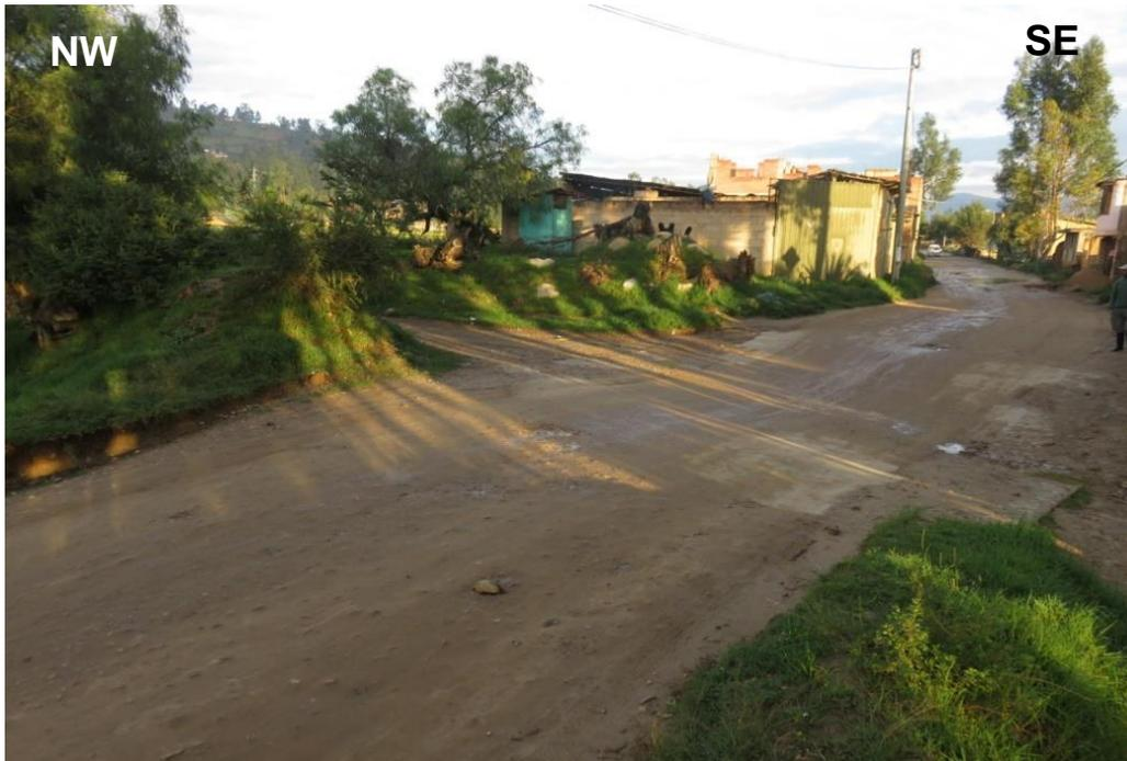
Figura 51. Se observa un badén de un ancho considerado, esto se debe al caudal de desfogue en épocas de lluvia es el mismo solo cambia la dirección de la fotografía tomada.
