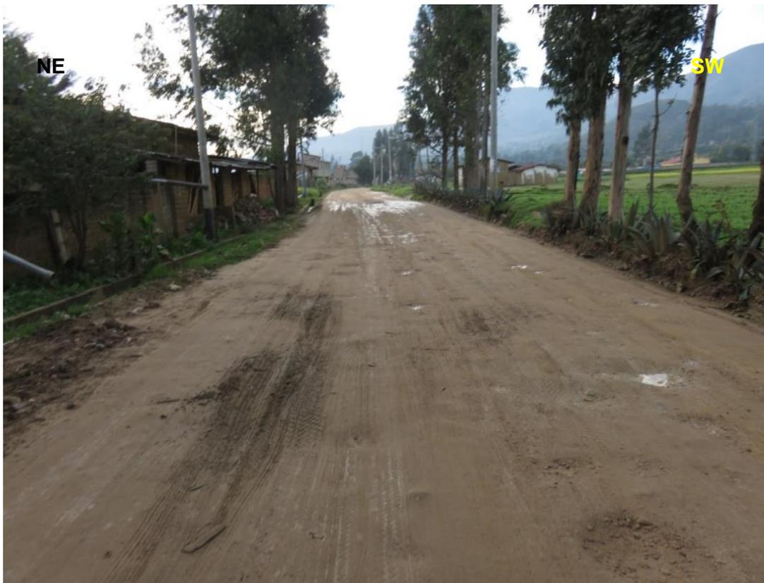
Figura 52. En esta parte de la vía se observa un ancho considerable y adecuada con su respectiva cuneta y acequia de regadío. Los árboles de eucaliptos generan un deterioro del canal de regadío.
