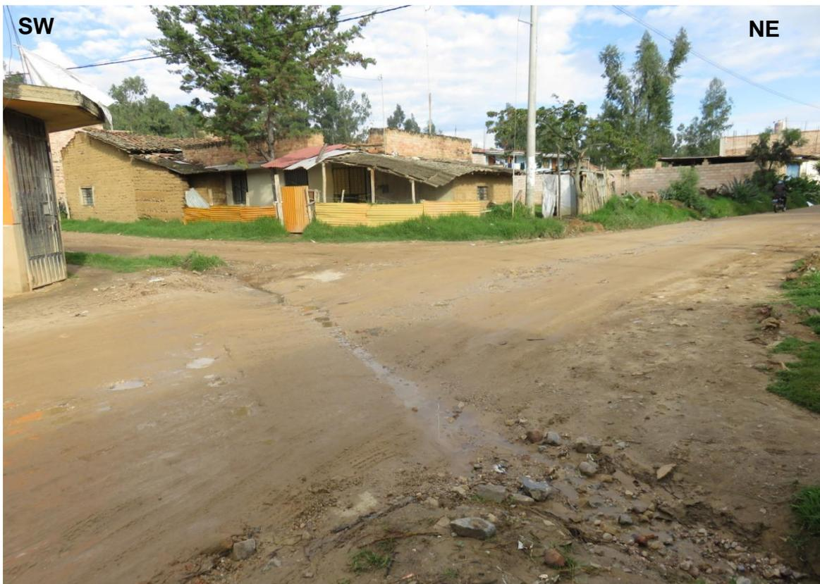
Figura 57. Se aprecia el badén en el paradero el Callejón sin mantenimiento continuo. En épocas de lluvia se produce inundación de este tramo. Esta entrada conduce al caserío de la Paccha Alta.
