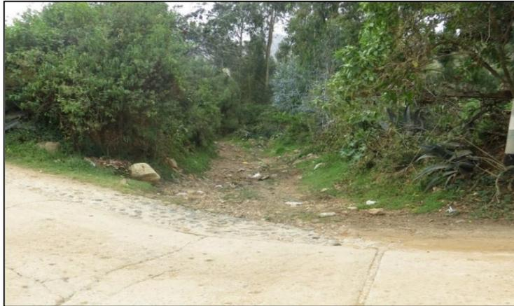
Figura 45. Podemos observar una quebrada el cual atraviesa la vía principal por medio de un badén con medidas considerables.
