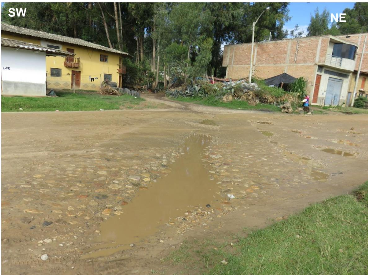
Figura 61. Se puede apreciar un badén de concreto armado con gravas y que no posee mantenimiento.
