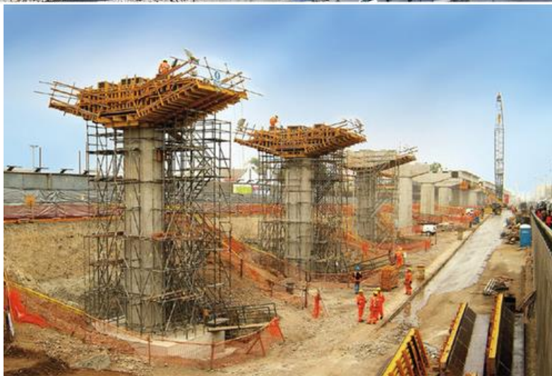
Figura 2.15 Construcción del Metro de Lima (Tamo I y II) por dovelas sucesivas. (Tomado de Catálogo ULMA).
