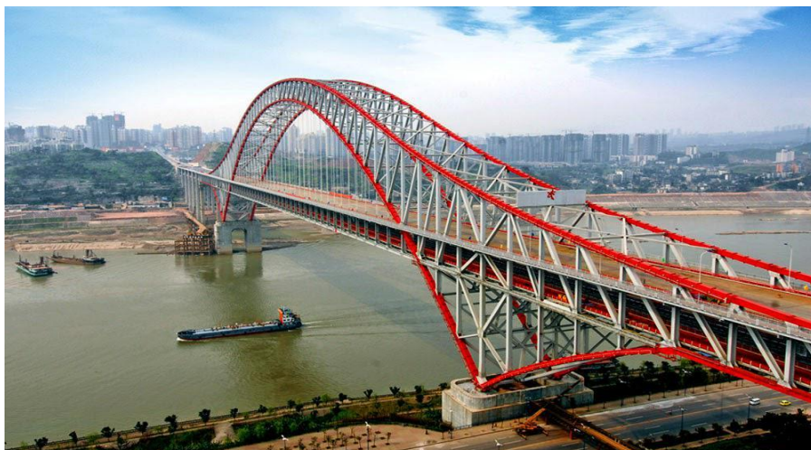
Figura 2.2 Puente Chaotianmen, China. Longitud total de 1741 m, con vano de 552 m.
