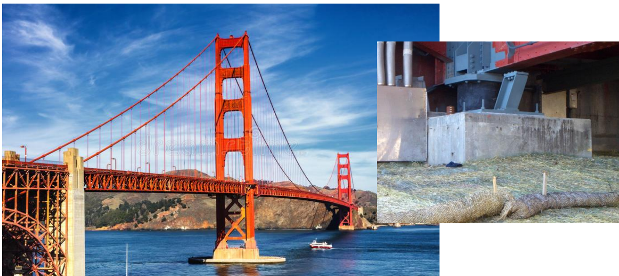
Figura 2.43 Puente Golden Gate, San Francisco (EE. UU) reforzado con aisladores elastoméricos.
