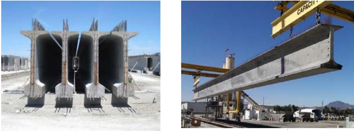
Figura 2.7 Vigas de sección I pretensadas (Tomado de Caltrans, 2015).
