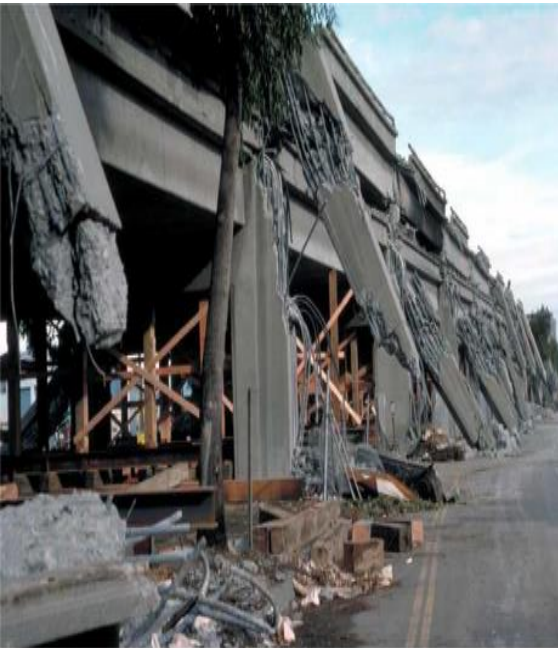
(c) Viaducto Cypress, Loma Prieta, 1989.
