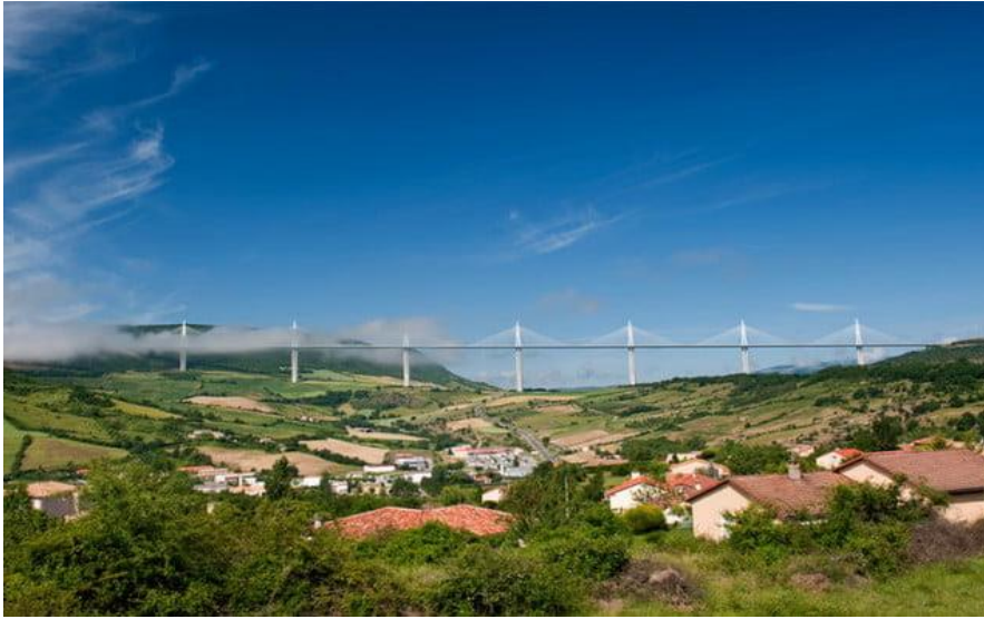
Figura 2.3 Viaducto de Millau, Francia. Longitud de 1.53 millas.
