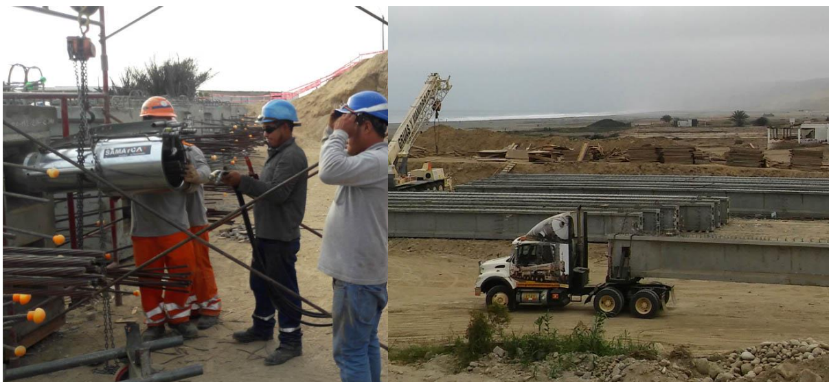
Figura 2.13 Vigas postensadas, Puente Topara, Ica (Tomado de Samayca Ingenieros SAC).
