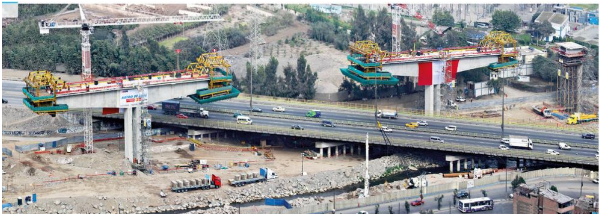
Figura 2.14 Sistema de 30 vigas postensadas de 40.6m de largo cada una, con torones de 7 y 13 cordones, Puente Pasamayito, Carretera Panamericana (Tomado de Freyssinet Tierra Armada Perú).
