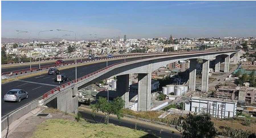
Figura 2.1 Puente Chilina, Arequipa-Perú. Longitud de 562 m.
