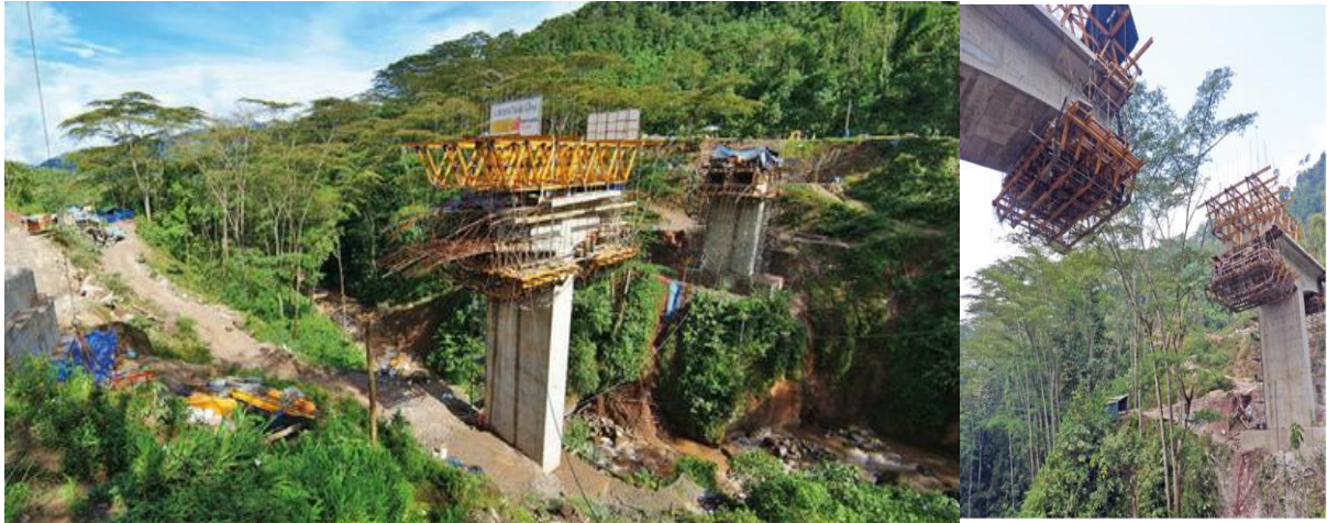
Figura 2.16 Construcción de Puenete Chino, Ucayali por dovelas sucesivas. Longitud 115m. (Tomado de Catálogo ULMA).
