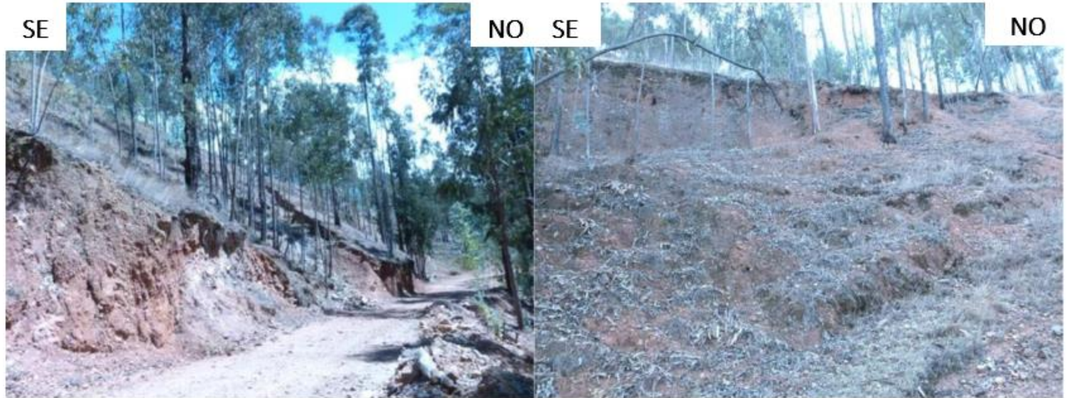
Figura 19. Deslizamiento-asentamiento sobre depósitos aluviales. Carretera de Mayopata Alta. Margen izquierda de la quebrada Mayopata
