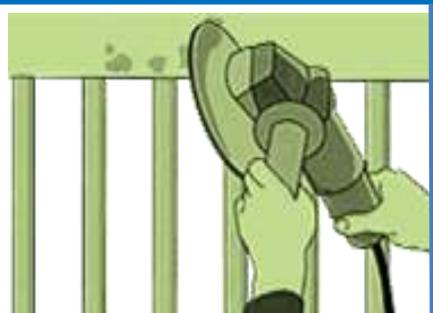
2° En estructuras sin tarrajeo, nivele la superficie retirando rebabes de concreto, con herramientas de desgaste, espátulas o lijas, para evitar el consumo excesivo de material y un total recubrimiento. Verificando que la superficie tenga cierta rugosidad.
