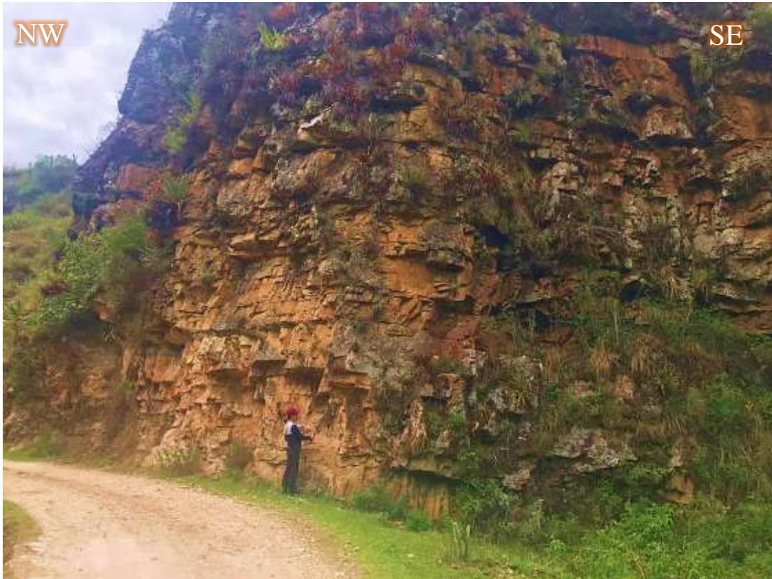
Foto N° 14. Talud de la estación N° 04, formada por macizos rocosos de areniscas.
