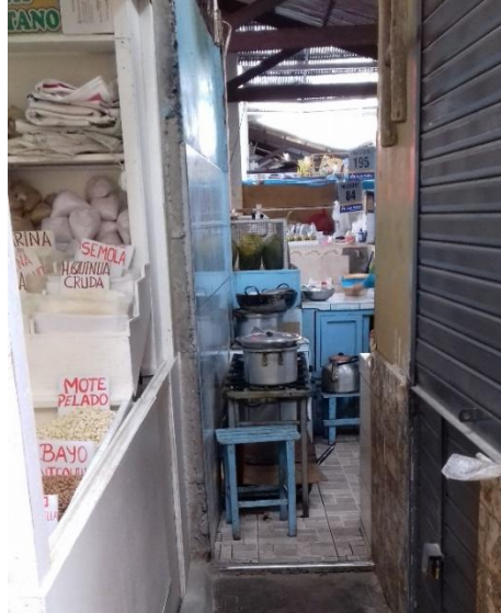
Figura 21: Inadecuado espacio para balones de gas.
