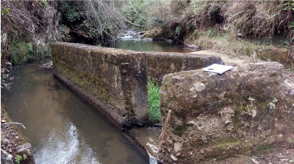
Figura 50.- Bocatoma de canal Tingo – El Ingenio.
