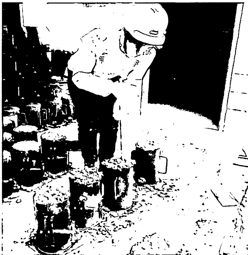
Foto N° 17: Llenado de los moldes con la mezcla de concreto.
