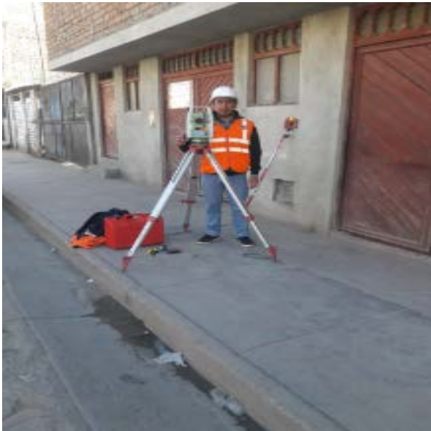
Fotografía 1: Equipo utilizado para el levantamiento topográfico de la vía.
