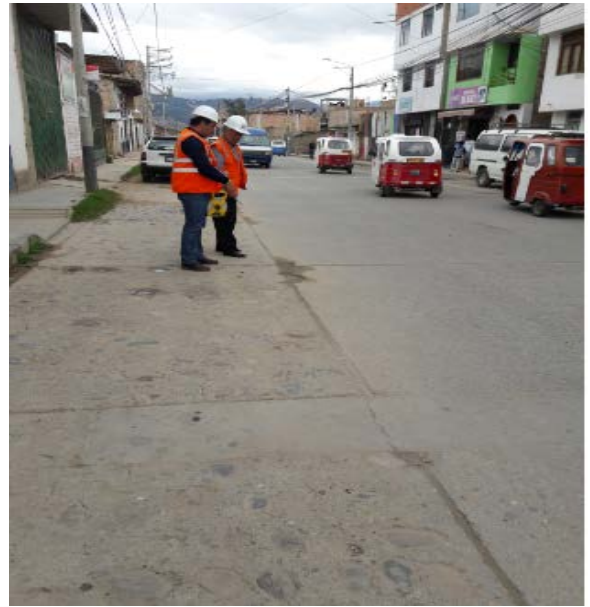
Fotografía 34: Descascaramiento de esquina de severidad baja.
