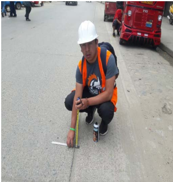
Fotografía 67: Desnivel carril berma de severidad baja.
