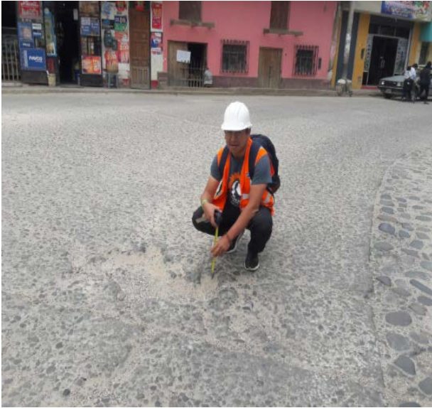
Fotografía 21: Pulimiento de la superficie
