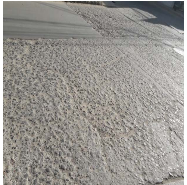
Fotografía 10: Pulimiento de la superficie.
