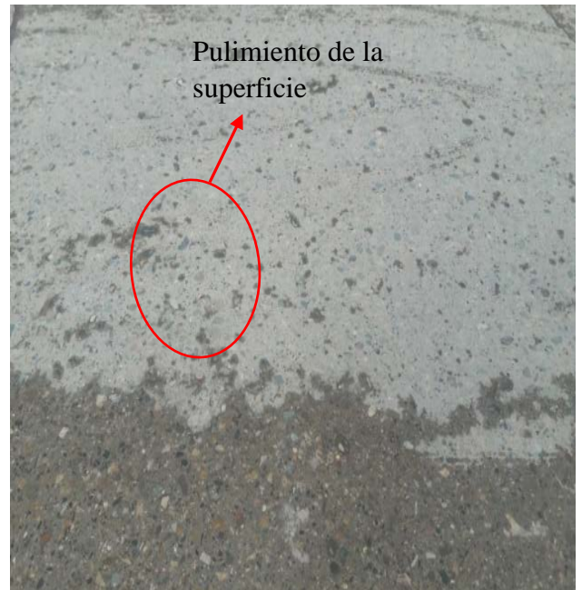
Fotografía 42: Pulimiento de la superficie.
