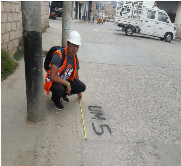
Fotografía 11: Pulimiento de la superficie, Grietas transversales de severidad media.
