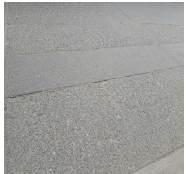
Fotografía 20: Pulimiento de la superficie.
