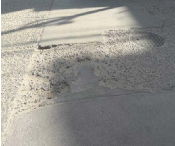
Fotografía 25: Pulimiento de la superficie y hundimiento.
