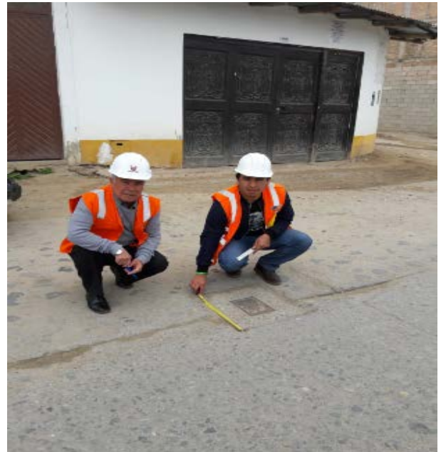
Fotografía 30: Parche pequeño deteriorado de severidad baja.
