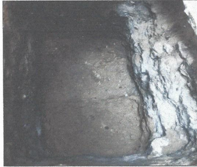
FOTOGRAFIA N° 01: SE OBSERVA LA CALICATA N° 01
