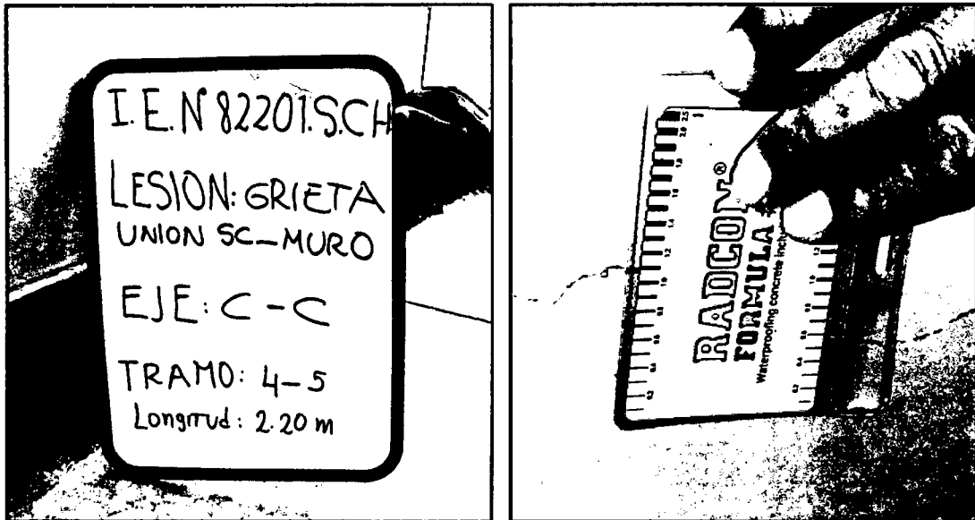
Imagen 18. Dimensiones de grieta en tabique de albañilería (eje C-C, tramo 4-5)
