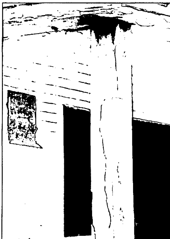
Figura 17. Fisuras características de una columna sometida a un exceso de compresión (Broto 2004)
