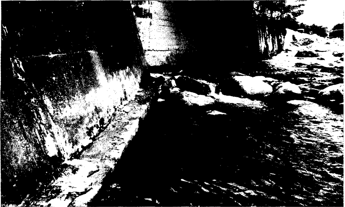
IMAGEN 01._Se observa la socavación al pie de los moros de encauzamiento en la parte derecha respecto al flujo (inicio del tramo: Puente Orellana-Puente Pardo y Miguel)
