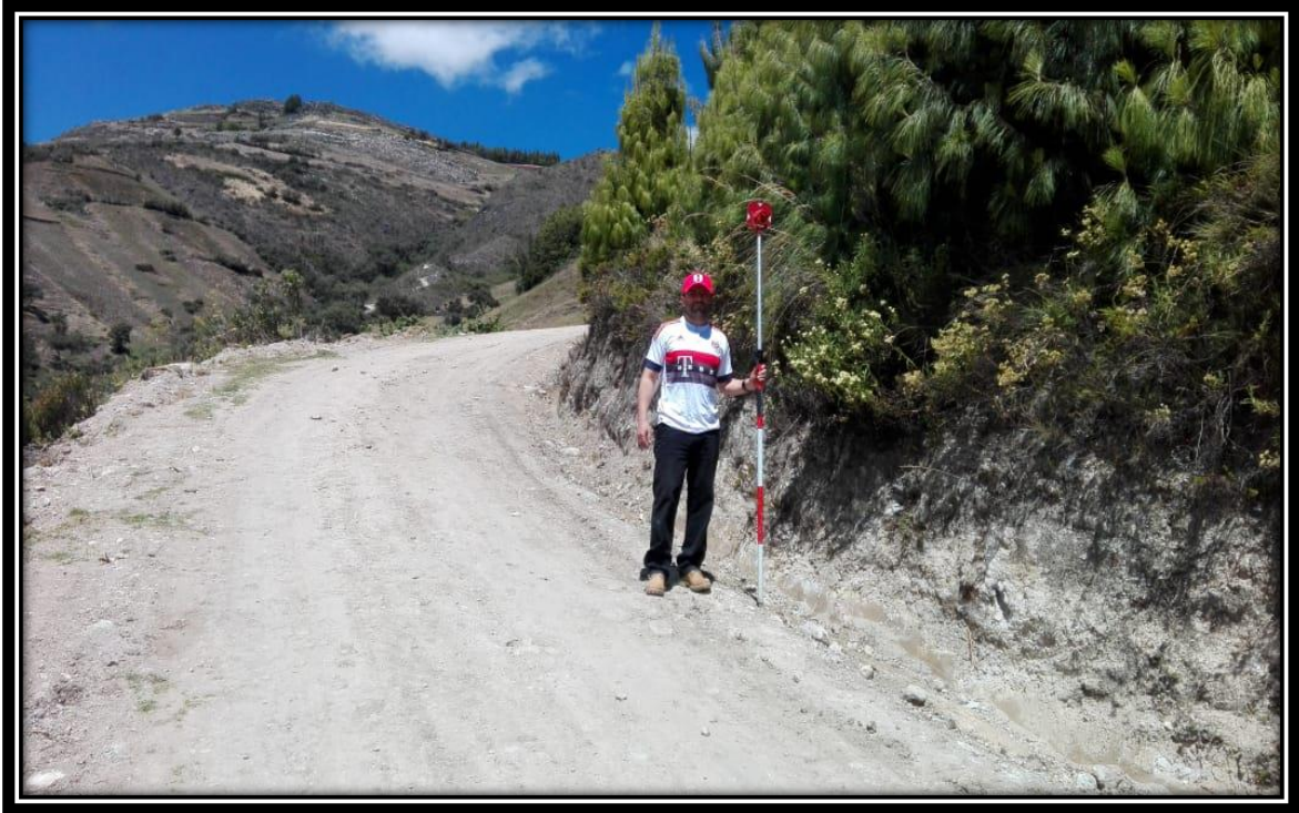
Ubicación de prisma al costado de la carretera para la toma de datos topográficos.
