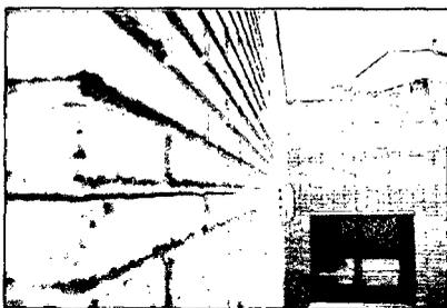
Fig. 1.95 Fisura por deficiencia de colocación del ladrillo
