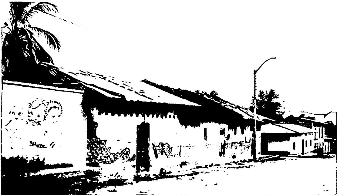
Figura 14. Vista de vivienda de adobe en la calle Tamborapa en pésimas condiciones para vivir como se pudo apreciar, además se encuentra al costado de un Centro Inicial (jardín).
