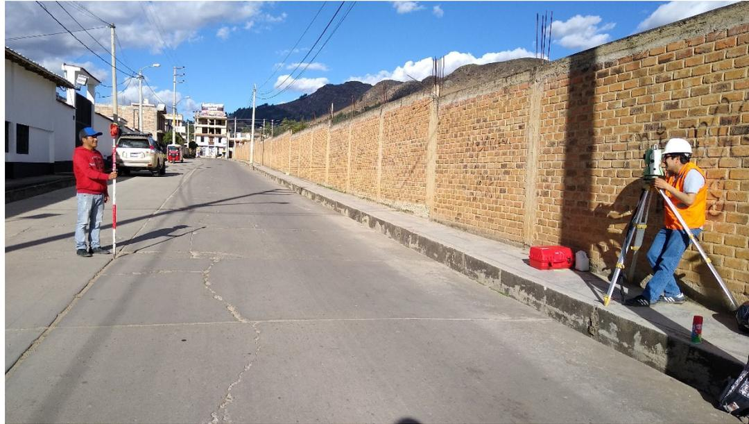
**Fotografía 1:** Levantamiento topográfico de la vía en estudio.
