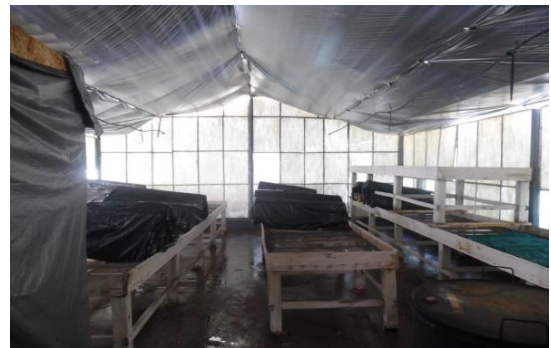
Foto N° 31. Acondicionamiento de invernadero.
