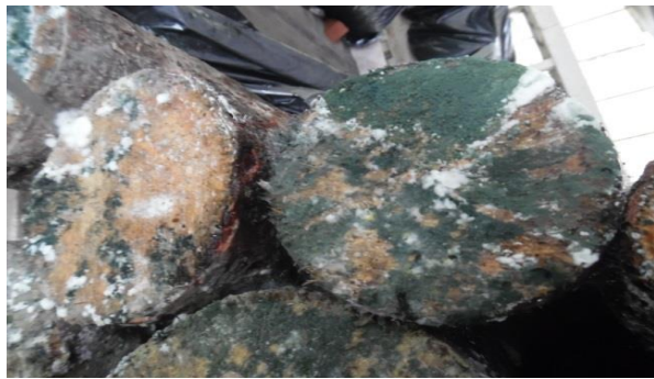
Foto N° 59. Presencia de hongos de pudrición negra.
